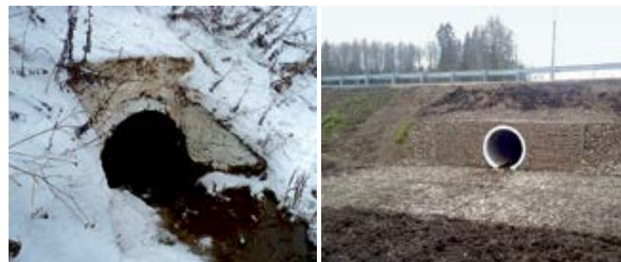
Рисунок 5.5. Ремонт водоотводной трубы. Материалы: Mapegrout Thixotropic, Mapelastic, Elastocolor Paint.
