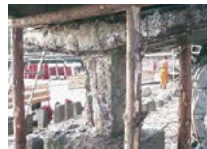
Рис. 3. Разрушение бетона маломассивной опоры с оголением и коррозией арматуры
