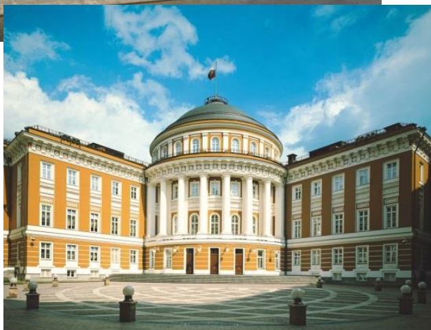
Здание №1 Московского Кремля
