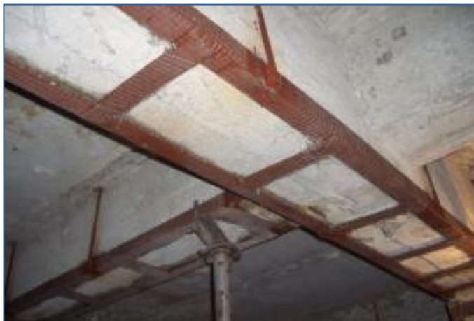
Усиление металлическим профилем
