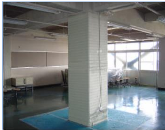
Сейсмоусиление колонн школьного здания (Япония)
