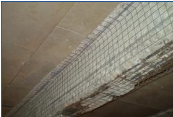
Усиление железобетонной обоймой
