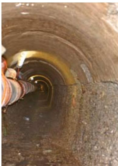
В качестве ремонтных материалов рекомендуется применение сульфатостойких или обогащенных эпоксидной смолой материалов.
