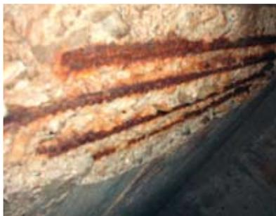
Трещины, образованные из-за отрыва бетонной облицовки, необходимо герметично закрыть подходящими цементными или полиуретановыми растворами для инъектирования от проникновения воды и дополнительного загрязнения грунтовых вод. Имеющиеся полости следует заполнить расширяющимися подливочными составами.
