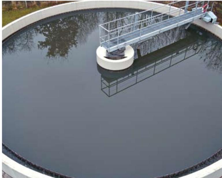
Потенциальным источником опасности для бетонных поверхностей очистных сооружений являются протекающие в сточных водах механические, биологические и химические процессы. Назовем лишь некоторые разрушающие бетон факторы: чередование циклов заполнения бассейнов (пустой цикл / заполнение сточными водами), воздействие агрессивных сточных вод и проход по верхней кромке бассейна рабочей поверхности илоскреба или подвижной фермы.
