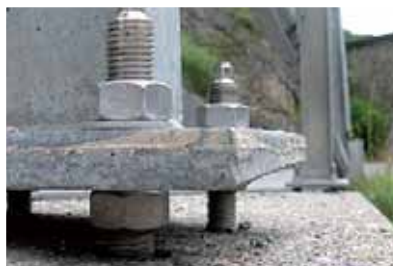
Анкеровка резьбовых и арматурных стержней
