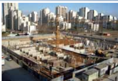
Производство на стройплощадке
