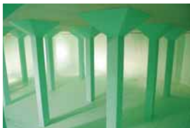
Гидроизоляция сооружений для питьевой воды
