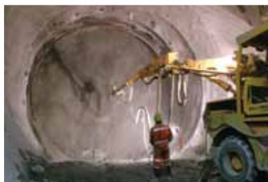
Нанесение торкрет-бетона
