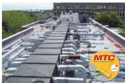
Ремонт кровли с помощью жидких мембран
