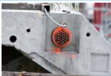
Цементация пучков из арматурных канатов
