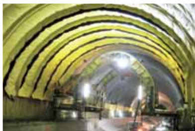
Гидроизоляция тоннелей
