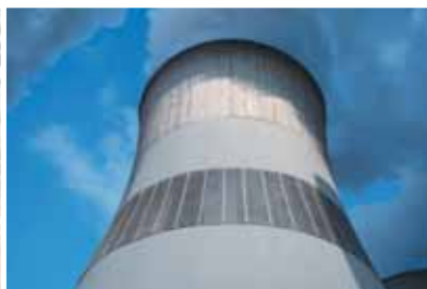
Дымовые трубы и градирни
