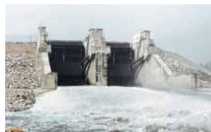
Защита бетонных конструкций от водного потока
