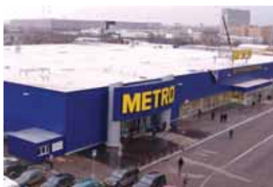
Кровли классические кровли, Москва (Россия)
