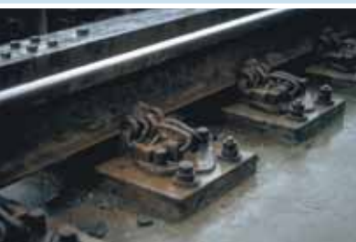
Эластичное крепление рельс
