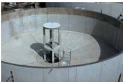
Швы водоочистительных сооружений
