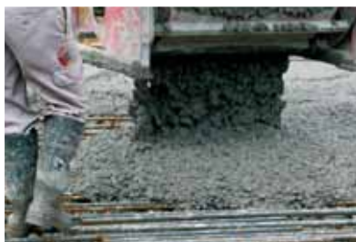
Применение специального бетона
