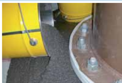
Подливка эпоксидной смолы
