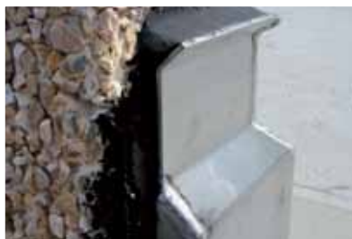
Кровельные стыковые соединения
