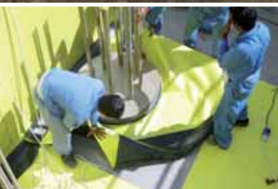
Гидроизоляция свай
