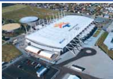
Нанесение логотипа на кровлю
