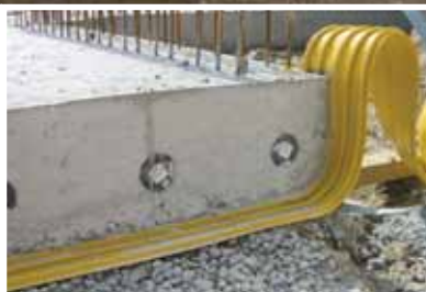
Гидроизоляция швов в конструкциях
