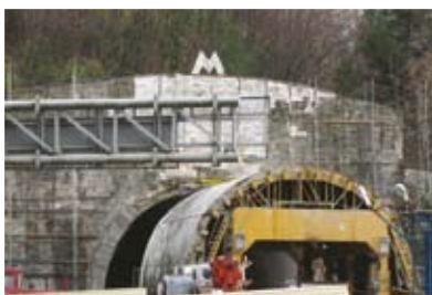
Строительство Хостинского тоннеля, Сочи (Россия)
