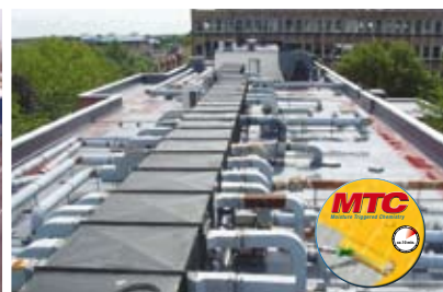
Ремонт кровли с помощью жидких мембран
