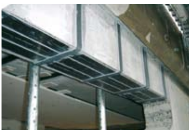
Усиление конструкции на сдвиг и изгиб системой Sika® CarboDur® Plates и Sika® CarboShear L
