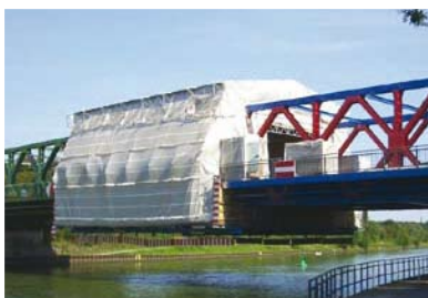
Работы по нанесению системы антикоррозионной защиты на металлоконструкции
