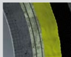
Гидроизоляция эластичными мембранами Sikaplan® WT / WP
