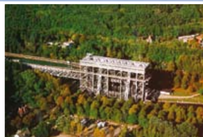
Применение системы антикоррозионной защиты металлоконструкций
