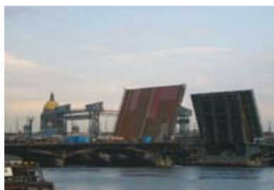
Нанесение антикоррозионных защитных покрытий. Благовещенский мост (Россия)
