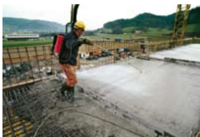
Нанесение средства по уходу за свежесделанным бетоном
