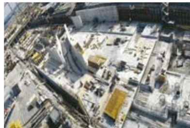
Добавки Sika® к бетону и гидрошпонки Sika® для строительства фундамента по типу «белая ванна»
