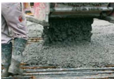
Применение специального бетона
