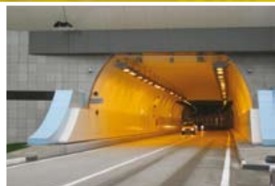
Обход г.Сочи. Тоннельный комплекс №6 (Россия)
