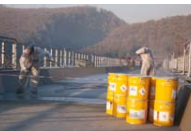
Гидроизоляция балластного корыта ПК 140 (Россия)
