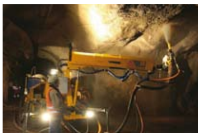
Укрепление свода тоннеля, Сочи (Россия)
