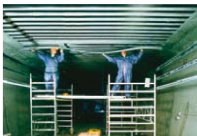
Приклеивание лент Sika® CarboDur® Plates
