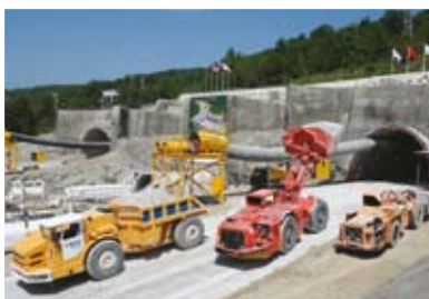
Южный портал первого тоннеля, Сочи (Россия)
