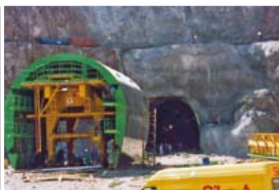
Строительство транспортной инфраструктуры гидроэлектростанции (Аргентина)
