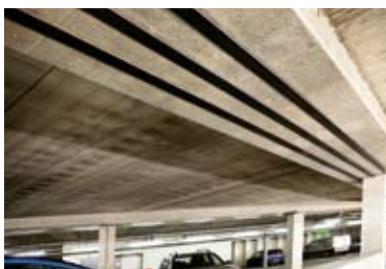
Усиленные конструкции зданий
