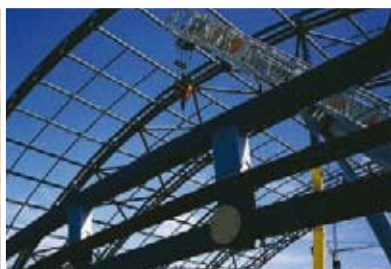
Нанесение системы антикоррозионной защиты на металлоконструкции
