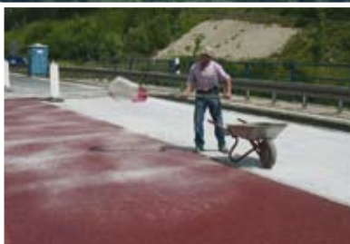
Гидроизоляция несущих конструкций моста
