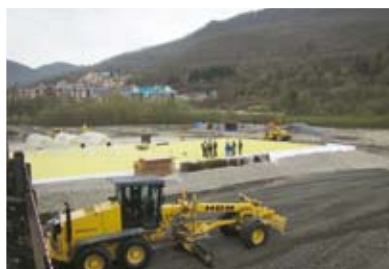
Строительство железнодорожного вокзала, направление Эсто-Садок (Россия)
