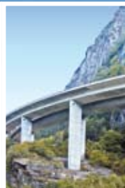
Ремонт, защита и усиление бетона
