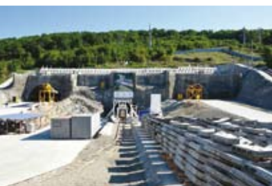
Строительство тоннельного комплекса, Сочи (Россия)
