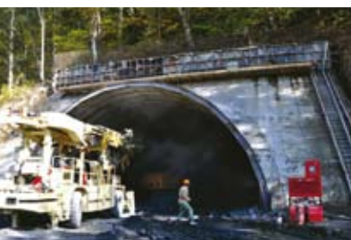
Строительство тоннеля, Сочи (Россия)
