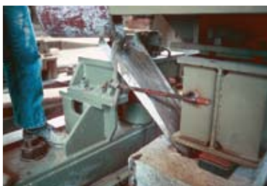
Подливка фундаментов и механизмов
