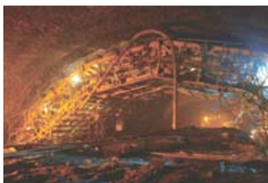
Строительство станции метро Чкаловская, Екатеринбург (Россия)
