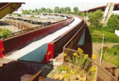
Гидроизоляция балластного корыта
