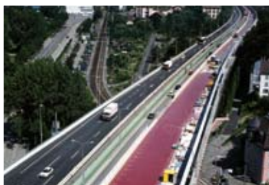
Гидроизоляционные материалы Sika® для ремонта путепровода (Китай)
