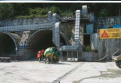
Строительство тоннеля в Сочи (Россия)
