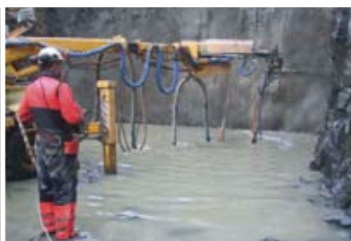
Работы по проходке тоннеля
