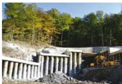
Строительство тоннеля, Сочи (Россия)
