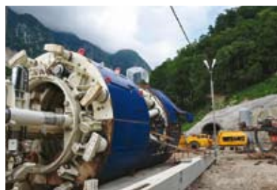
Оборудование для проходки тоннеля щитом, Сочи (Россия)
