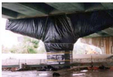
Усиление конструкции опоры моста (Россия)
