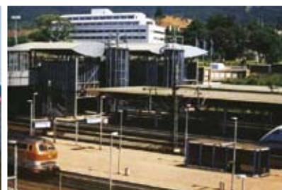
Железнодорожные пути вокзала после реконструкции, Кессель-Вильгельмское (Германия)
