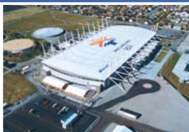
Нанесение логотипа на кровлю
