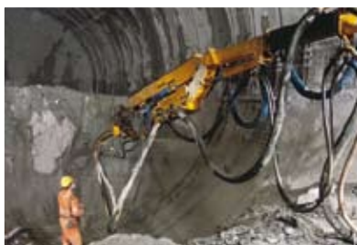
Работы по проходке тоннеля
