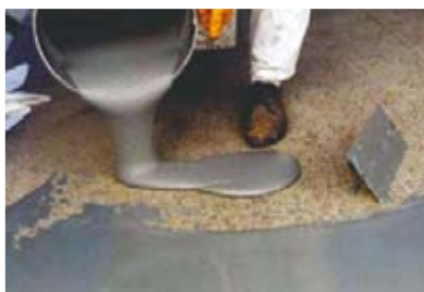
Работы по гидроизоляции балластного корыта
