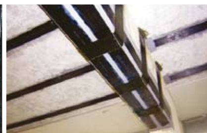
Применение системы усиления Sika® CarboDur® CFRP
