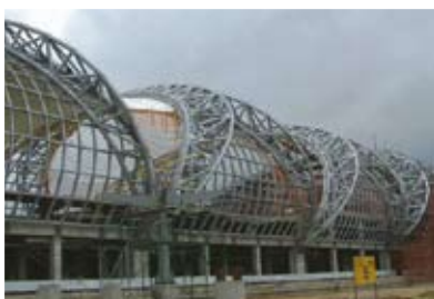
Строительство аэропорта в Бангкоке (Таиланд)
