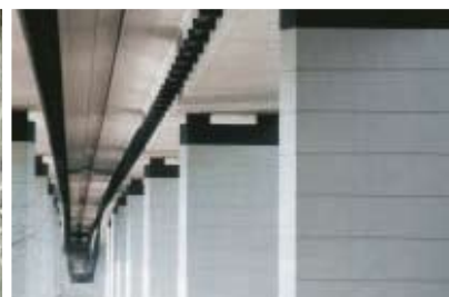
Применение системы усиления Sika® CarboDur® System
