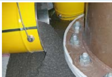
Подливка эпоксидными составами
