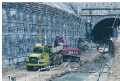
Строительство тоннеля (Швейцария)
