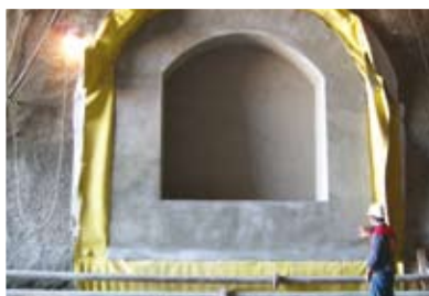
Гидроизоляция мембранами Sikaplan
