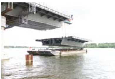
Строительство моста через р. Висла (Польша)
