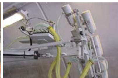
Нанесение огнезащитного состава роботом
