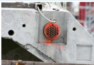
Подливка пучков из арматурных стержней
