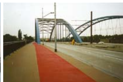
Гидроизоляция несущих конструкций моста (Германия)
