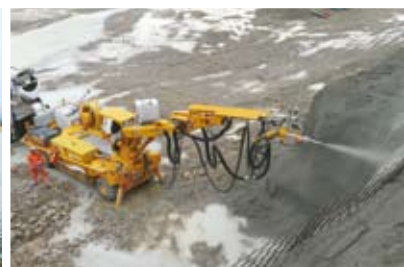
Нанесение торкретбетона на подпорную стену
