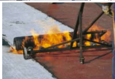
Гидроизоляция покрытия моста
