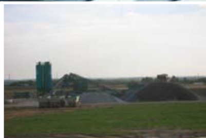
Подготовка грунта под строительство взлетной полосы (Германия)
