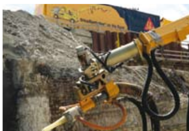
Укрепление откосов торкретированием, Сочи (Россия)
