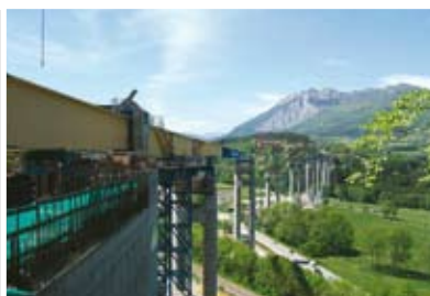
Строительство виадука, Монестьер (Франция)
