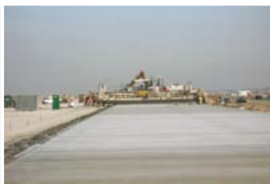
Строительство бетонной дороги (Россия)
