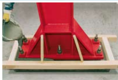
Подливка цементными составами
