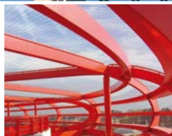
Антикоррозионная и противопожарная защита конструкций
