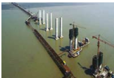
Строительство моста, Сутонг, 32,4 км (Китай)
