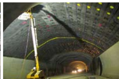
Автомобильный тоннель N 20.1.4- Birmensdorf-Hafnerberg (Швейцария)
