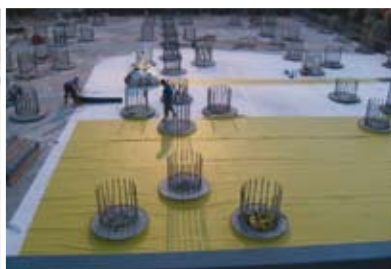
Гидроизоляция фундамента Адлеровского железнодорожного вокзала (Россия)
