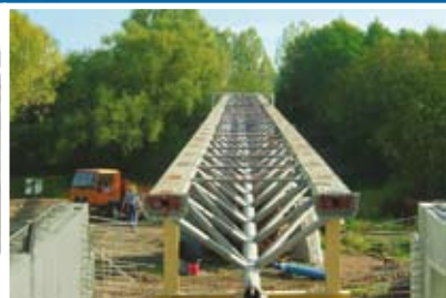
Строительство моста, Кассел (Германия)
