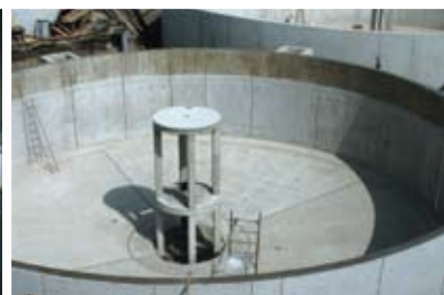
Швы резервуаров водоочистных сооружений
