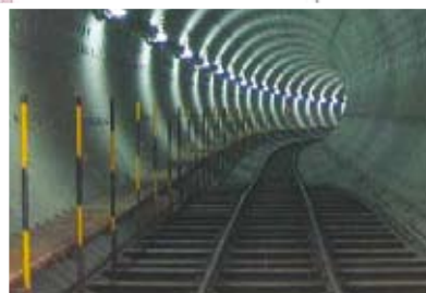
Укладка рельсового полотна в тоннеле метро в Шанхае (Китай)
