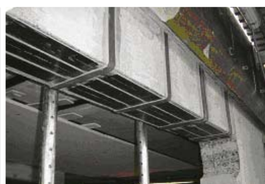
Применение системы усиления Sika® CarboDur® CFRP
