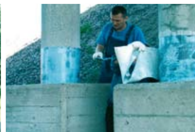
Приклеивание полимерного нетканного материала серии SikaWrap® Fabric System
