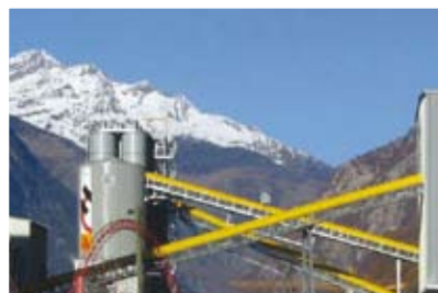
Добавки в бетон при строительстве основного тоннеля Gotthard (Швейцария)
