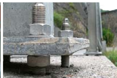
Подливка оборудования и конструкций
