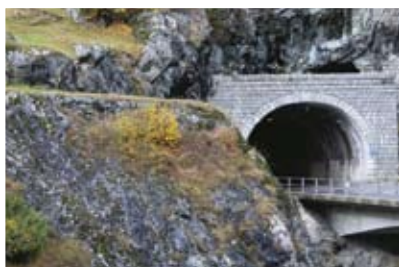
Автомобильный тоннель N 20.1.4 Birmisdorf-Hafnerberg (Швейцария)
