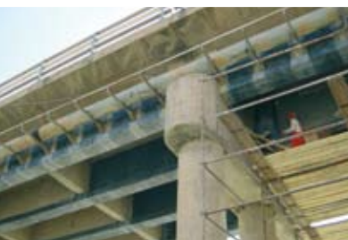
Работы по усилению конструкции моста
