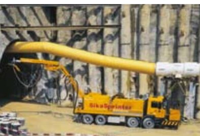
Строительство тоннеля Готтхарда (Швейцария)
