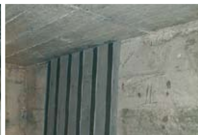
Усиление конструкции на изгиб лентами Sika® CarboDur® Plates
