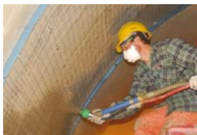
Нанесение огнезащитного состава
