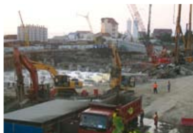
Строительство железнодорожного вокзала, Адлер (Россия)
