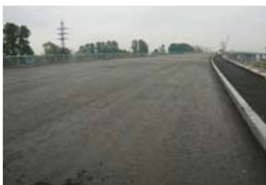
Гидроизоляция несущих конструкций Митрофаньевского моста (Россия)
