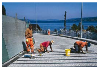
Приклеивание и дожатие лент Sika® CarboDur® Plates
