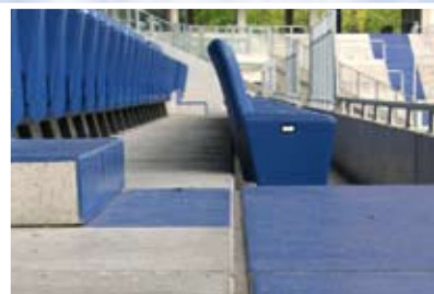
Герметизация деформационных швов напольных покрытий
