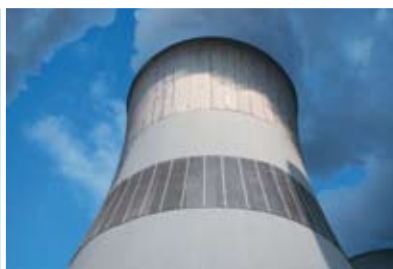
Дымовые трубы и градирни
