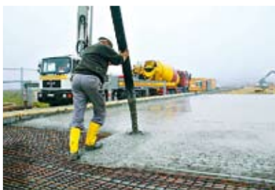
Подача бетонной смеси с помощью насоса
