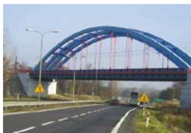
Железнодорожный мост над дорогой Е67 (Белоруссия)
