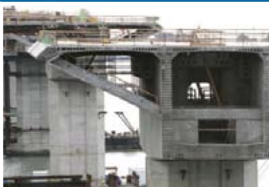
Монтаж конструкций моста, Сан-Франциско (США)
