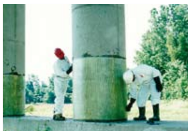
Усиление колонн моста полимерным нетканым материалом серии SikaWrap® Fabric System
