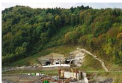
Строительство тоннеля Sinard (Франция)
