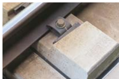
Технология эластичного крепления рельс (Япония)
