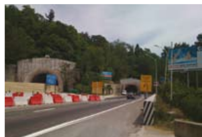
Обход г. Сочи. Тоннельный комплекс №6 (Россия)
