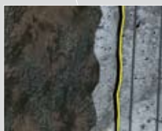
Торкретбетон SikaCem®Gunit ®, Sigunt ®, Sika® ViscoCrete SC 305 , Sika® Gunit 03
