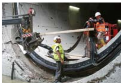
Секционирование при гидроизоляции тоннелей
