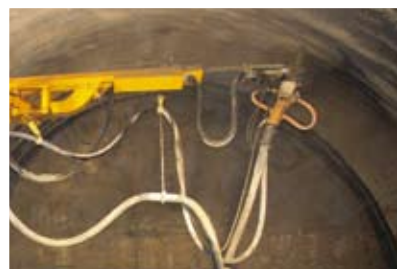
Укрепление сводов тоннеля торкретированием, Сочи (Россия)
