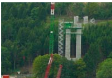
Строительство виадука, Монестьер (Франция)
