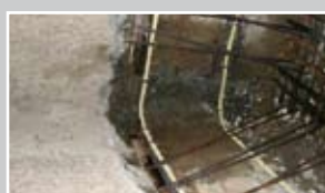
Присоединение к существующей конструкции
