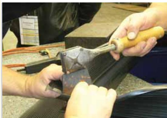
3. Сварку необходимо проводить вдвоем. Электрический топор подключается к сети и нагревается в течение примерно 5–10 мин. до достижения необходимой температуры.
