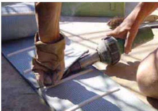
2. Поместить концы гидрошпонок друг на друга внахлест. Ширина нахлеста - минимум две ширины сопла промышленного фена. Сварить гидрошпонки с одной стороны, прижимая верхнюю шпонку к нижней, до образования сварочного валика. Фен располагается поперек гидрошпонки вдоль сварного шва.
