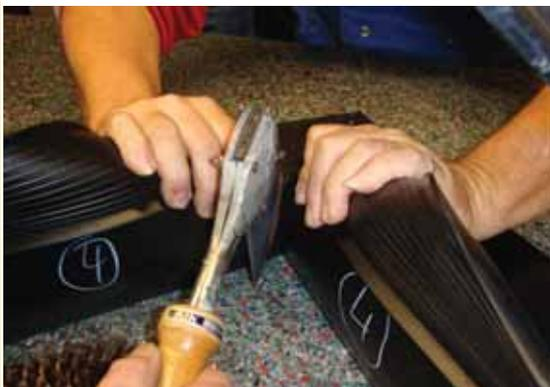
4. Сварку гидрошпонок для деформационных швов рекомендуется начинать с деформационного канала и затем вести по очереди к обоим краям.
