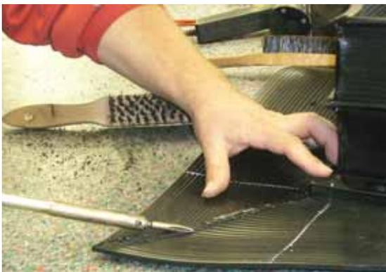
8. Сварной шов после остывания проверяется на герметичность. Предварительная проверка осуществляется с помощью отвертки, окончательная — с помощью искрового тестера.
