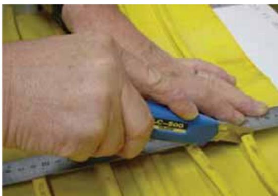
2. Отрезать необходимую часть гидрошпонки. Для сварки прямого стыка очень важно, чтобы срез был ровный. Для облегчения разреза, нож можно подогреть ручным феном.
