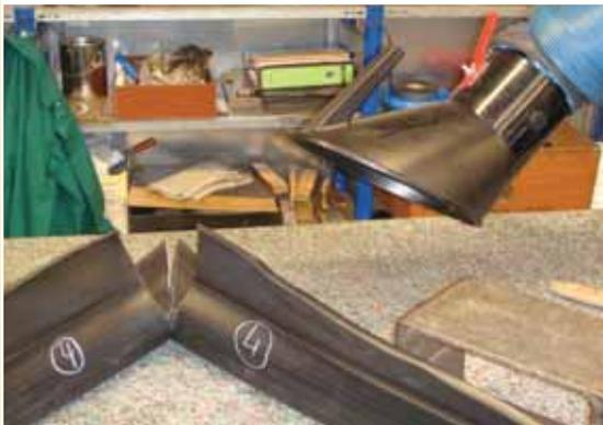
1. Отрезать необходимые части гидрошпонок. Срез должен быть ровным. Для облегчения разреза, нож можно подогреть ручным феном.
