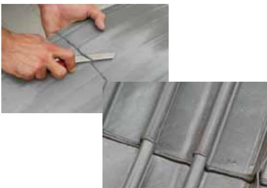
7. Валик сварного шва должен присутствовать на протяжении всего шва. Если есть непроваренные места, их необходимо дополнительно проварить. Это возможно выполнить с помощью насадки ручного фена, горячего воздуха, небольшой локальной заплатки. Если качественно заварить шов невозможно, его необходимо вырезать и сварить заново.
