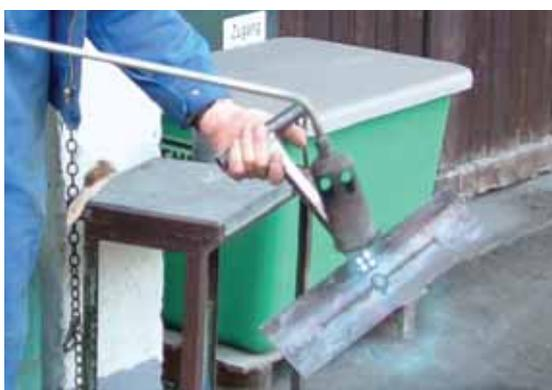
4. Нагреть медную пластину газовой горелкой. Необходимо добиться оптимальной температуры для сварки. Нагреть медную пластину необходимо до появления зеленоватого оттенка пламени. Перегретая нагревательная пластина сожжет гидрошпонку, а недостаточно нагретая не сможет качественно сварить шов.
