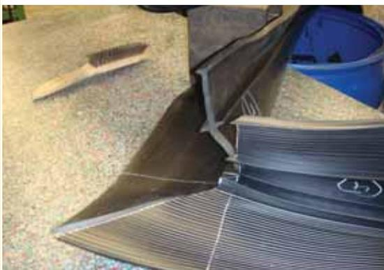
2. Приложить подготовленные концы гидрошпонок друг к другу, проверить на прилегание, при необходимости подогнать срезы таким образом, чтобы между концами гидрошпонок не было зазоров.
