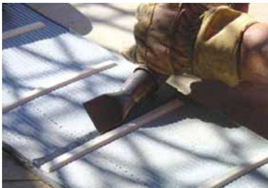
4. На сварочном валике необходимо снять фаску. Сопло строительного фена после завершения работ очищается металлической щеткой.
