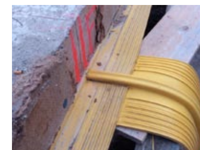
■ пример угловой стыковки гидрошпонок
