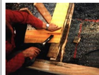
■ сварка гидрошпонок внахлест
