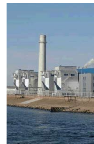
Россия, Санкт-Петербург, Центральная Станция Аэрэции
