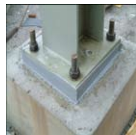
После снятия опалубки (на следующий день)
