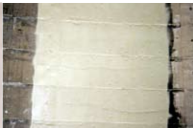
Эпоксидное защитное покрытие Icosit 2406 , обладающее способностью к герметизации поверхностных пор и высокой укрывистостью.
