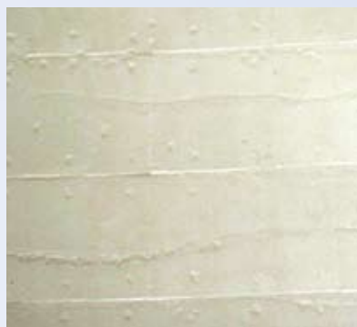
Эпоксидное покрытие Icosit®-2406 , нанесенное на внутреннюю поверхность градирни.
