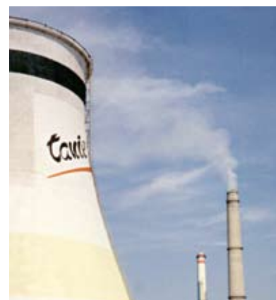
Наружные поверхности подвергаются воздействию дымовых газов от расположенных вблизи дымовых труб.
