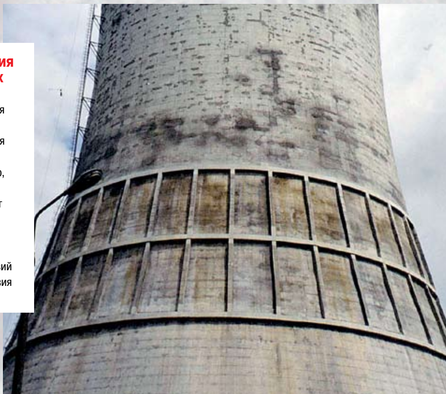
Ускоренная коррозия арматуры и эрозия бетона в зоне воздействий кислотных дымовых газов.
