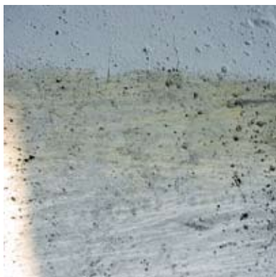
Поверхность бетона без выравнивающего и порозаполняющего покрытия.
