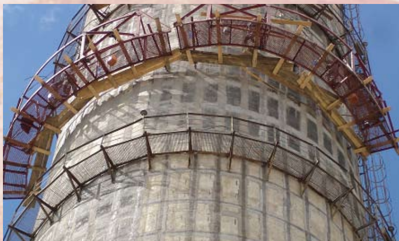
ТЭЦ-11 ОАО «Иркутскэнерго». Нанесение клеевого состава Sikadur-330 на углеродные холсты SikaWrap-530C для усиления ствола дымовой трубы.
