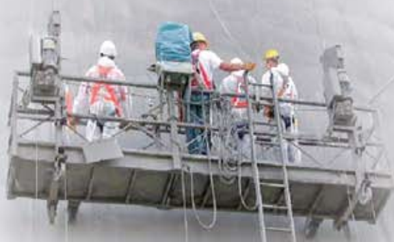
Специалисты по ремонту и защите бетона во время обследования поверхности градирни.
