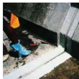
гидроизоляция трещин
