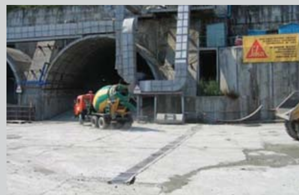
Сочи/Россия Строительство тоннеля закрытым способом, мембрана Sikaplan®WP 2110-15HL2 (Sikaplan®9.6V TU), добавки для производства торкрет-бетона, гидрошпонки, штуцеры
