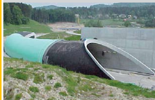
Birmensdorf/Швейцария Строительство открытым способом, мембрана Sikaplan®WT 1200-30C
