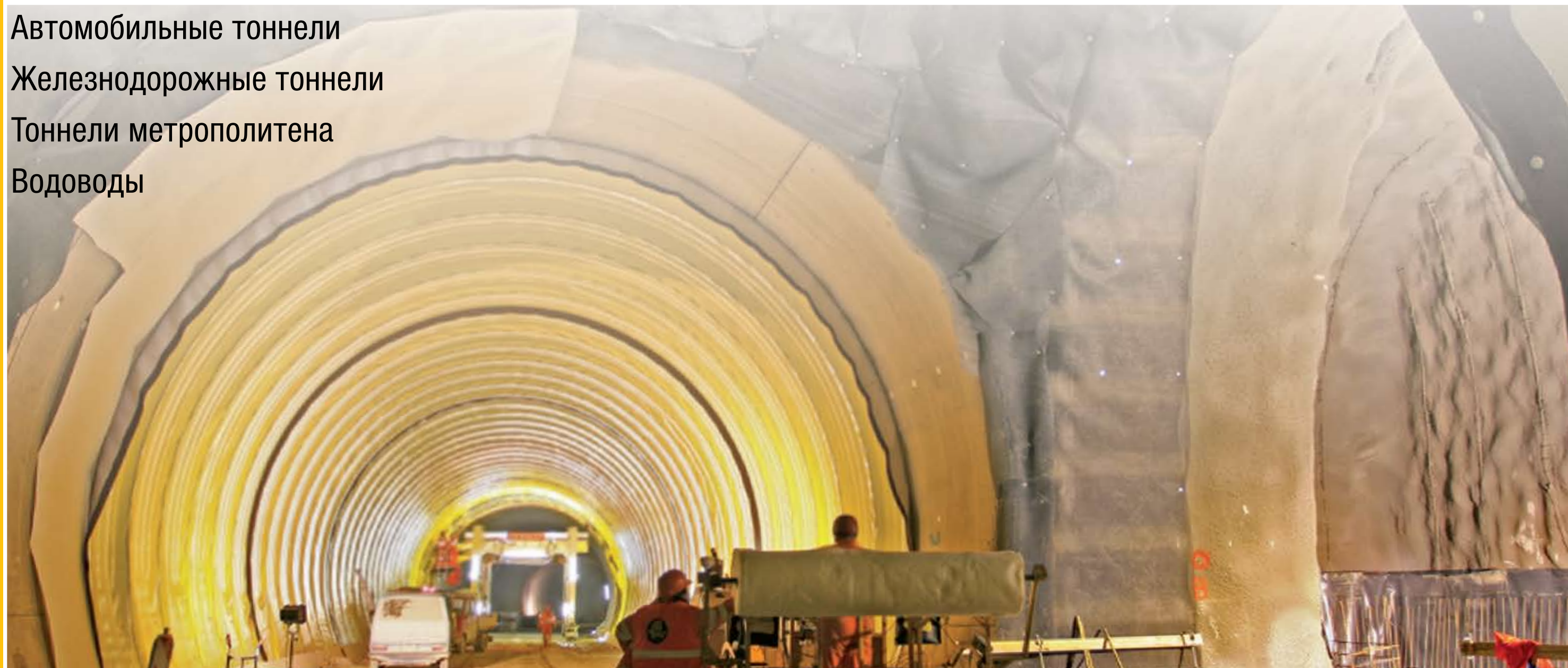
Islisberg/Швейцария, проходка щитом, Sikaplan®WP 2110-20HL, крепление сваркой
