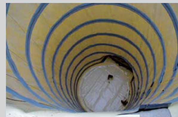
NBS Франкфурт – Кёльн/Германия Эвакуационный выход, Sikaplan®WT 2200-31HL2 и гидрошпонки MP AFI 600/35
