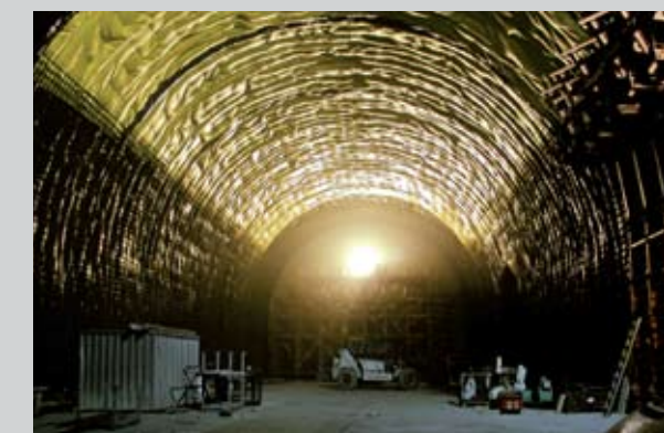
Lötschberg/Швейцария Строительство тоннеля закрытым способом, мембрана Sikaplan®1.46 NEAT
