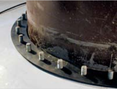
Соединение с прижимным фланцем при наличии давления воды
