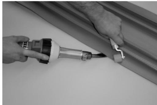
Предварительно прихватите мембрану **Sikaplan® WP**, потом окончательно ее приварите. Если необходимо соединять гидрошпонки **Sika® Waterbars** на объекте, остановите сварку на расстоянии 50 см до края гидрошпонки **Sika® Waterbars**. Завершите сварку используя готовые элементы гидрошпонок **Sika® Waterbars**.
