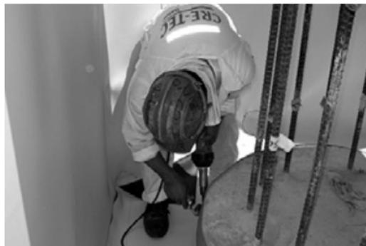
Верхний край сваи должен быть в одном уровне с краем гидрошпонки. Закрепите арматурные стержни в соответствии со строительной документацией. Залейте гидротехническую бетонную смесь, или альтернативно, сначала залейте 10–15 мм эпоксидного подливочного раствора, в область гидрошпонки (потом, после затвердевания эпоксидного раствора, будет залита стандартная бетонная смесь).
