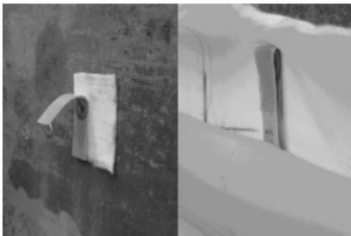
Точечная фиксация методом “подтяжек”: под-держивающая полоса, вырезанная из гидрои-золяционной мембраны, пристреливается дю-белями монтажным строительным пистоле-том (например, система Hilti DX) к стене. Рулон мем-браны затем точно приваривается к этой под-держивающей полосе.
