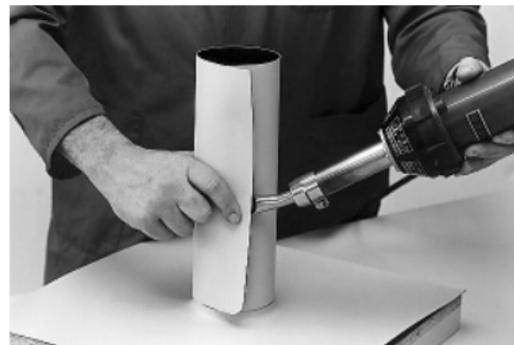
Измерьте куском мембраны **Sikaplan® WP** периметр изолируемой трубы и добавьте на нахлест 30 мм для сварного шва
