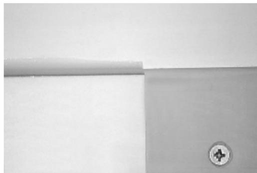
При необходимости ламинированную ПВХ жесьть дополнительно загерметизировать клеем-герметиком типа **Sikaflex® -11 FC**.
