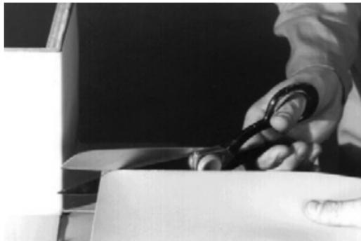
Вырежьте накладку на угол, оставляя запас материала. Затем закруглите уголок, который будет располагаться на вертикальном двухгранном углу.
