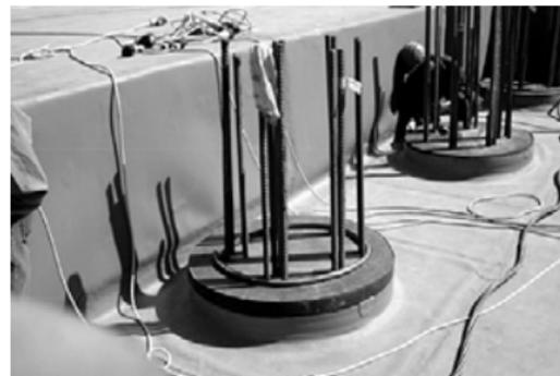
После удаления опалубки, очистите поверхность гидрошпонки от цементного молочка, масла или других загрязнений. После этого приварите горячим воздухом гидроизоляционную мембрану к гидрошпонке.
