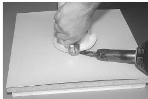
... и окончательно приварите "юбку" к мембране **Sikaplan® WP**, используя силиконовый прикаточный ролик шириной 20 мм.
