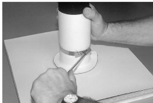
Наденьте получившуюся заготовку из мембраны на трубу и временно закрепите ее с помощью стяжного хомута.
