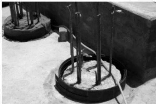
Сделать опалубку вокруг оголовка сваи на уровне фундаментной плиты. Вставьте наружную гидрошпонку из ПВХ **Sika® Waterar** в опалубку, плоской стороной к опалубке.
