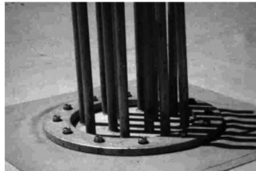
Расположение стяжных болтов должно быть размечено на сваренной мембране, отверстия должны пробиваться пуансоном по диаметру равным диаметру болта. Приварите горячим воздухом подготовленное герметизирующее кольцо вокруг вводного отверстия на гидроизоляционной мембране.
