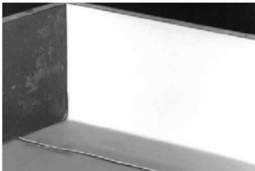
Точно отрежьте первую полосу, уложите ее без складок на вертикальной поверхности, после чего приварите к мембране **Sikaplan® WP** на горизонтальной поверхности.
