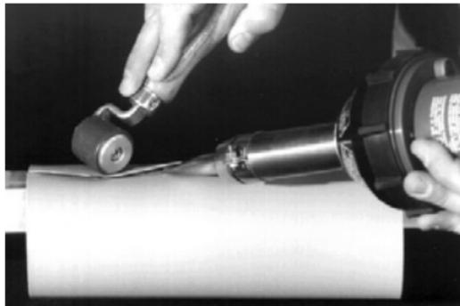
Используя вспомогательную рейку, сначала сделайте предварительную, а затем окончательную сварку заготовки из мембраны
