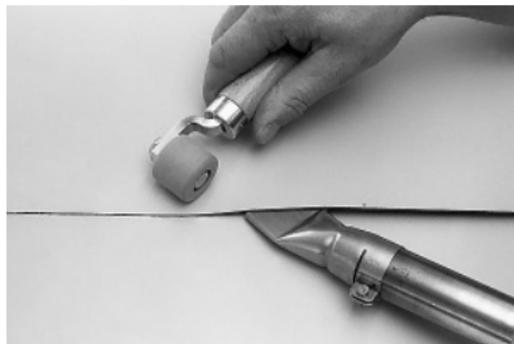
Для сварки прямых швов используйте насадку шириной 40 мм, Насадка шириной 20 мм используется при сварочных работах в углах, на примыканиях и при устройстве сложных деталей.
