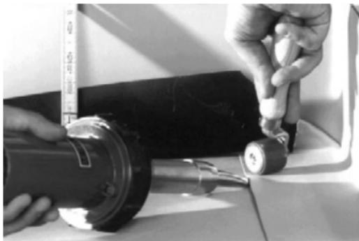
Сначала точно прихватите, а затем полностью приварите горизонтальную часть «опуска» мембраны **Sikaplan® WP** к основной гидроизоляционной мембране **Sikaplan® WP**.
