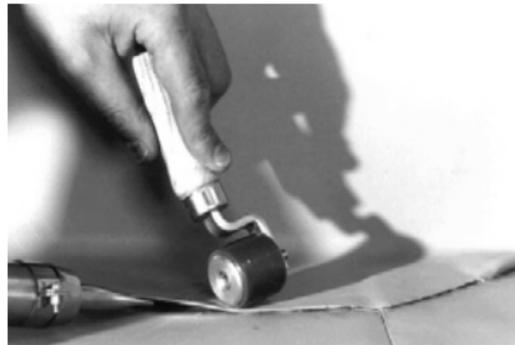
Приварка нахлеста к гидроизоляционной мембране **Sikaplan® WP**. После охлаждения сварного шва проверьте шов отверткой (шлиц шириной 5 мм).
