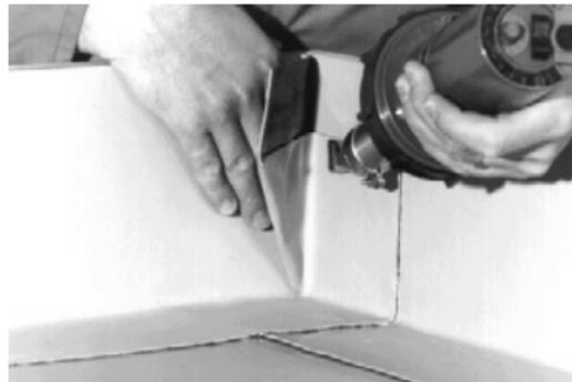
Начиная с угла, приварите заваренный “карман” к вертикальному усилению (сначала предварительная сварка, потом окончательная). Завершите приварку вертикального нахлеста.
