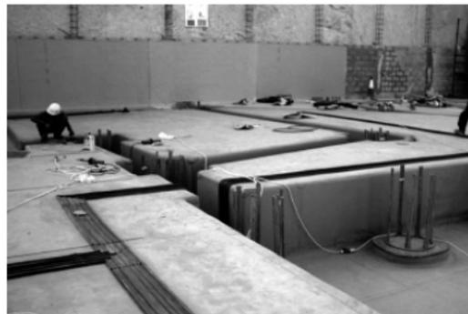
Подготовленные гидрошпонки нужно уложить в соответствии с проектом, после этого боковые стороны гидрошпонки привариваются горячим воздухом с помощью полуавтоматического аппарата Leister Triac Drive.
