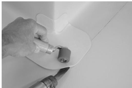
Из заранее изготовленного уголка из мембраны **Sikaplan® WP** вырежьте деталь, подходящую по размерам. Точно зафиксируйте ее в углу и также на вертикальной поверхности, после чего окончательно приварите ее к гидроизоляционной мембране **Sikaplan® WP**. Всегда ведите сварку от центра наружу к краям.
