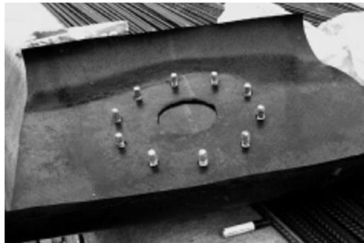
Прорежьте отверстия в гидроизоляционной мембране соответственно размерам деталей. Подготовленные секции гидроизоляционных мембран, включая уплотнительные кольца, соединяются вместе и стягиваются с прижимным фланцем (на мембране не должно быть складок и герметизирующее кольцо не должно быть деформироваться под прижимным фланцем).
