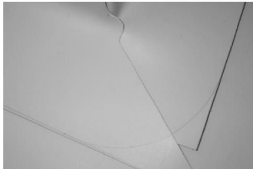
Подрежьте нахлест вдоль края скруглите угол. Оставьте небольшой выпуск для сварки нахлеста. Завершите сварку.
