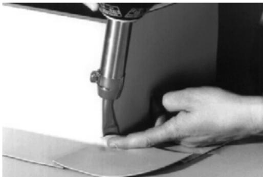
Начиная от угла, приварите вертикальную часть заплатки из **Sikaplan® WP** к вертикальному двухгранному углу. Сварка проводится снизу вверх.
