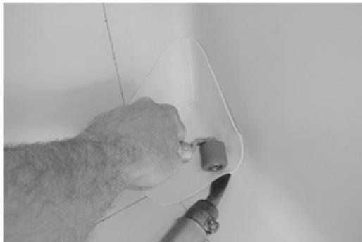
Расположите заранее отформованный уголок из **Sikaplan® WP** и приварите его к гидроизоляционной мембране **Sikaplan® WP**. Всегда проводите сварку от центра к краям.
