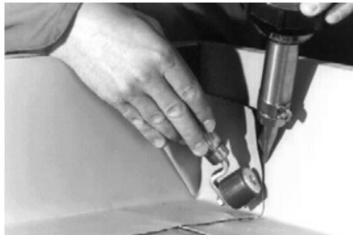
Приварите верхнюю часть полосы на вертикальную поверхность первой полосы и на горизонтальную поверхность гидроизоляционной мембраны **Sikaplan® WP**.
