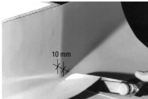
На нижней стороне нахлеста сделайте под прямым углом разрез не доходя 10 мм до вертикального двухгранного угла.
