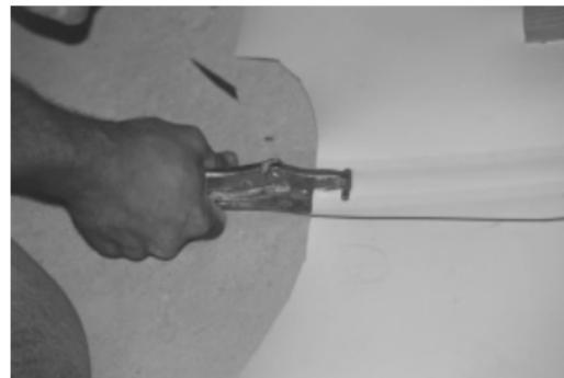
После этого, зажмите с помощью второго зажима другой конец проверочного воздушного канала между швами сварного шва и протестируйте шов, накачивая требуемое давление воздуха. Давление зависит от типа и толщины материала мембраны, температуры окружающей среды и составляет 1,5 – 2,5 бар в зависимости от температуры от плюс 40 °С до минус 10 °С и для толщины мембраны от 2 до 3 мм.
