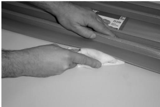
Протрите и очистите поверхность будущей сварки в соответствии с рекомендациями, которые были даны в разделе "Очистка / подготовка поверхности шва".
