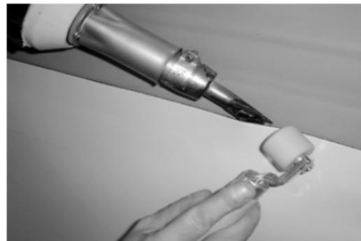
А) Приварка гидроизоляционных мембран **Sikaplan® WP** на гидрошпонки **Sika® Waterbars**. Удалите все загрязнения, пыль и т.п. с поверхности гидрошпонки **Sika® Waterbars**.
