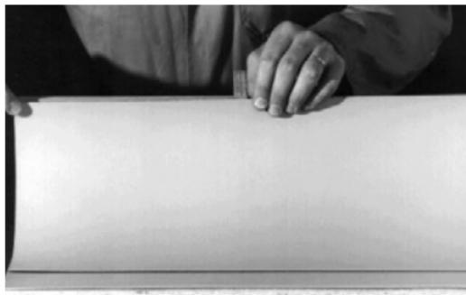
Согните мембрану под углом 90° и точно прихватите ее на сгибе к горизонтальной поверхности гидроизоляционной мембраны.
