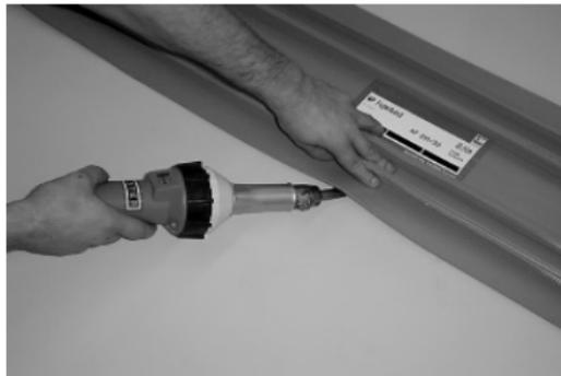
В) Приварка гидрошпонок **Sika® Waterbars** на гидроизоляционные мембраны **Sikaplan® WP**. Расположите гидрошпонку **Sika® Waterbars** и точно прихватите ее вдоль обоих краев.
