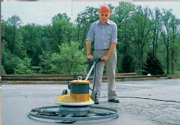
Затирочная машина с регулируемой скоростью вращения для затирки бетонных поверхностей и полимерных полов
