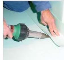
Сварка ручным феном Leister Triac PID
