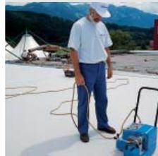
Сварка мембран при помощи аппарата Sarnamatic
