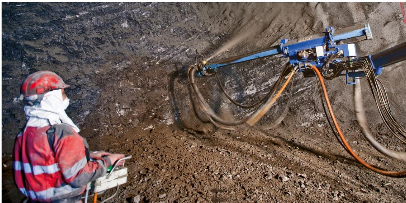
Технология набрызг-бетона должна обеспечивать безопасность работ и демонстрировать высокие эксплуатационные характеристики в течение длительного времени. Компания BASF предлагает широкий ассортимент добавок, которые можно использовать при изготовлении бетона на БРУ, а также непосредственно на площадке.
