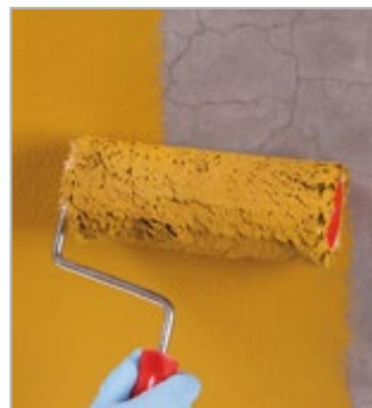
Рис. 8.12 – QUARZOLITE BASE COAT
