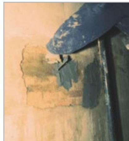
Рис. 5.5 – Ремонт отслоившейся штукатурки с помощью NIVOPLAN+PLANICRETE
