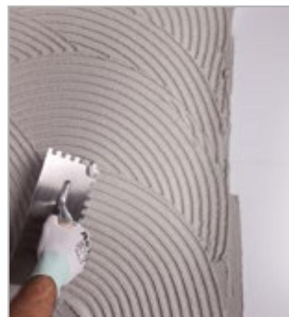
Рис. 5.15 – Нанесите первый слой выравнивающего и разглаживающего раствора
