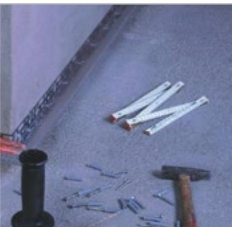
Рис. 5.6 – Установка поддерживающих профилей. Проверьте их горизонтальности с помощью уровня
