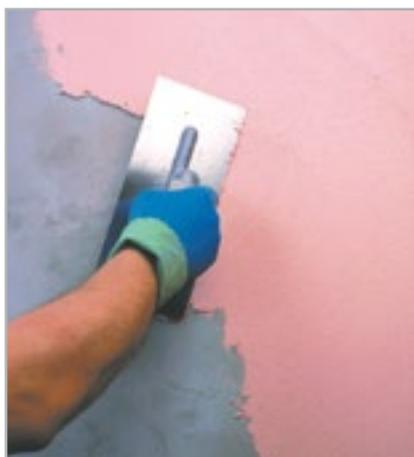
Рис. 5.18 – Нанесите слой отделочной штукатурки
