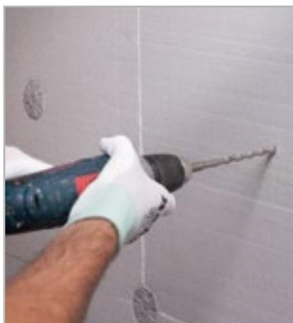
Рис. 5.12 – Просверлите отверстия для дюбелей
