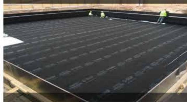
**2** Закрепить самоклеящуюся ленту MasterSeal 934 вертикально по углам с помощью скобы в ее верхней части. Самоклеящаяся сторона всегда обращена в сторону бетонирования. Снять защитную пленку с самоклеящегося углового элемента MasterSeal 754 IC и соединить с вертикальной лентой. Аналогично операцию повторить в горизонтальных углах.
