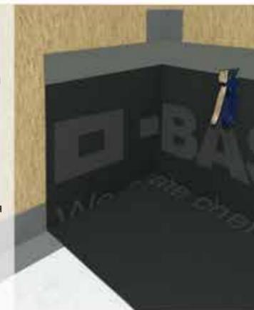
**5** на каждом боковом краю мембраны MasterSeal 754 предусмотрена самоклеящаяся кромка 100 мм шириной. Края мембран должны соприкасаться друг с другом, однако допускается отклонение до 5 мм. Следует избегать нахлеста мембранных листов. Далее необходимо снять защитную пленку с самоклеящейся кромки и аккуратно склеить края мембран между собой.
