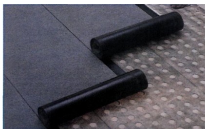
Рис. 26 - Устройство «вентилируемой» кровли с применением перфорированного материала
