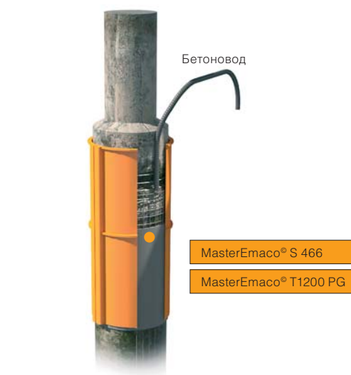
Ремонт с применением опалубки
