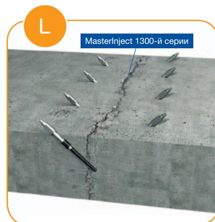
**Герметизация активных и статичных трещин** посредством инъектирования полимерных составов MasterInject 1300-й серии
