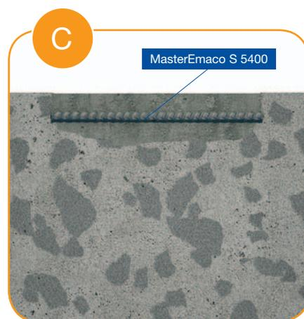
**Устранение дефектов дна отстойника**, возникающих в результате абразивного износа при попадании посторонних предметов под скребок илоскреба
