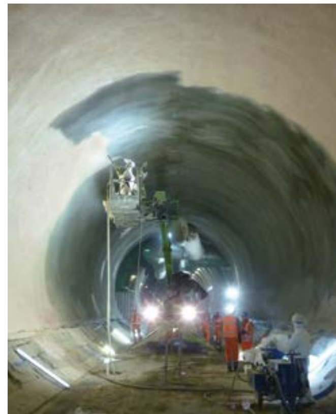
Нанесение гидроизоляционной мембраны MasterSeal 345
