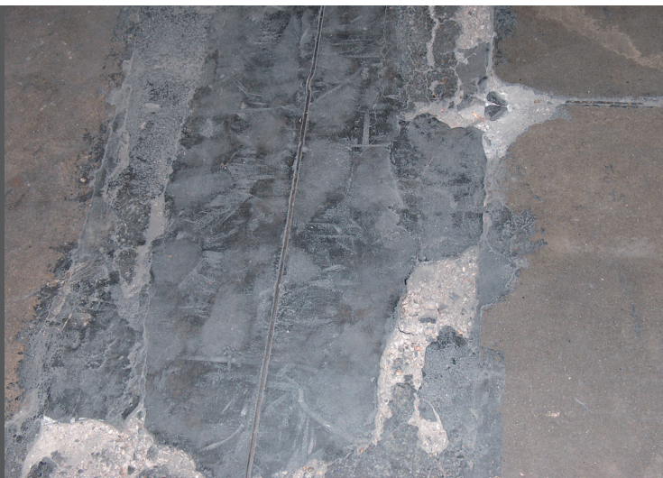
фото 20 Разрушенный бетон
