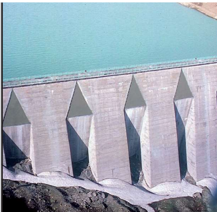
Фото 15. Конструкция, гидроизолированная при помощи MAPELASTIC.
