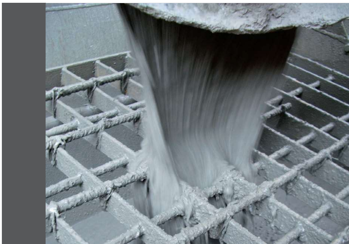
Фото 12. Сверхподвижный бетон, приготовленный с использованием Stabilcem SCC.
