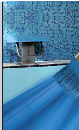
Фото 18. Нанесение Elastocolor Waterproof.
