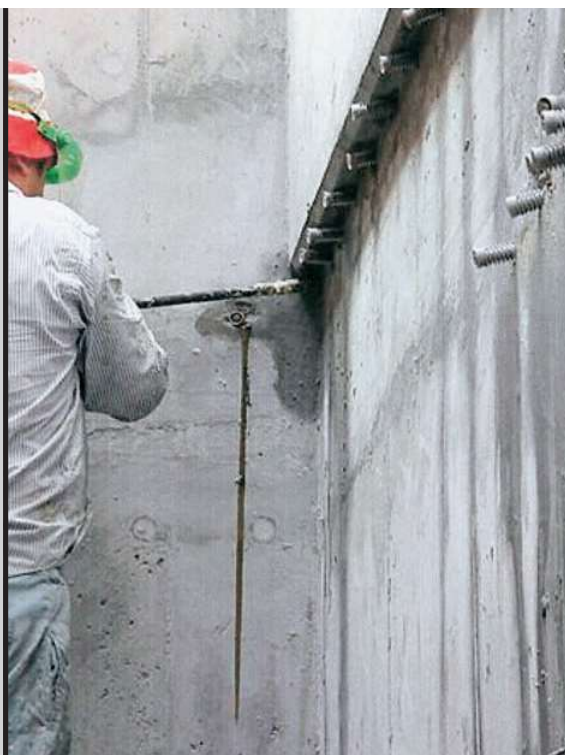
Фото 13. Инъектирование Foamjet F.
