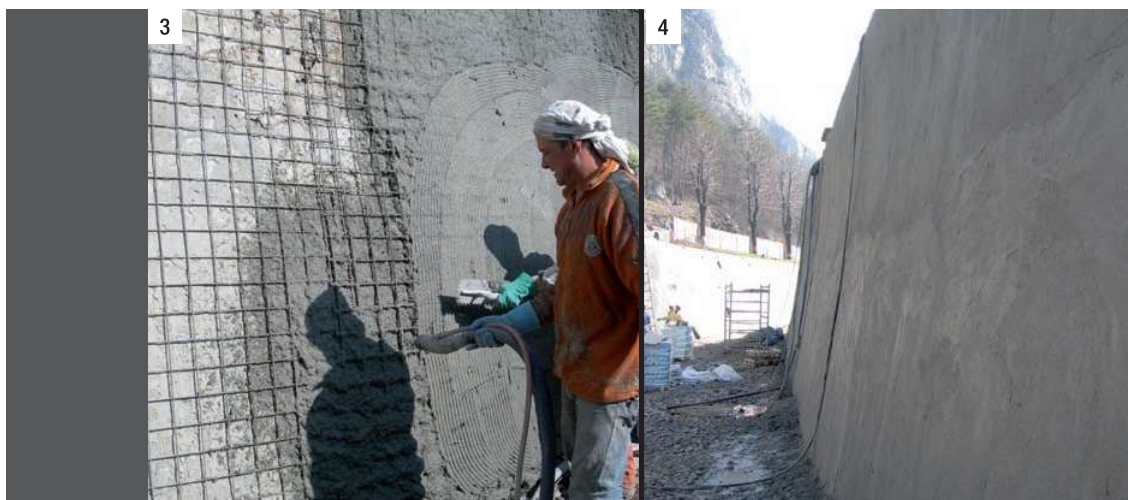
Фото 3. Нанесение Mapegrout Easy Flow механизированным способом.
