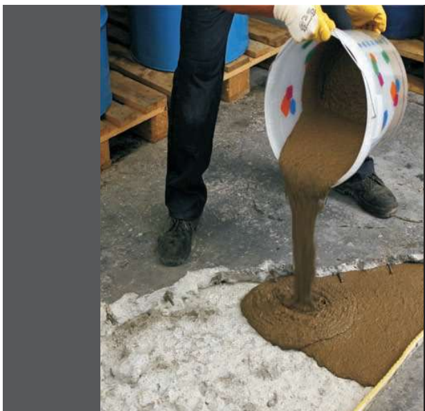
Фото 11. Ремонт полов использованием Mapegrout SV Fiber.
