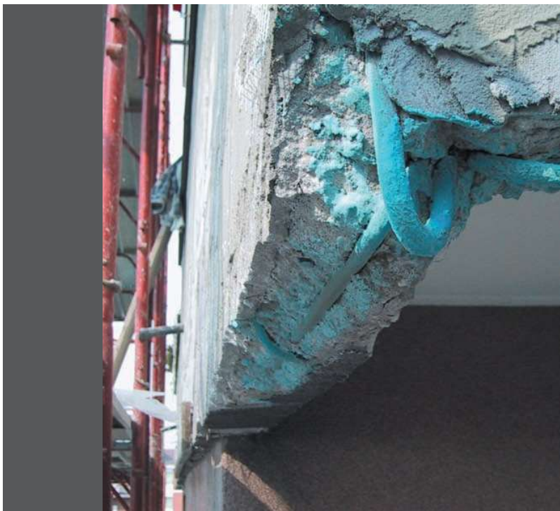
Фото 1. Нанесение антикоррозионного раствора на арматурные стержни.
