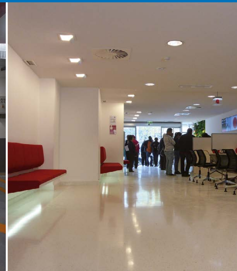
Офис EDP Company – Лиссабон – Португалия Напольное покрытие: Mapecolor I 300 SL эффект «Венецианский терракцо»
