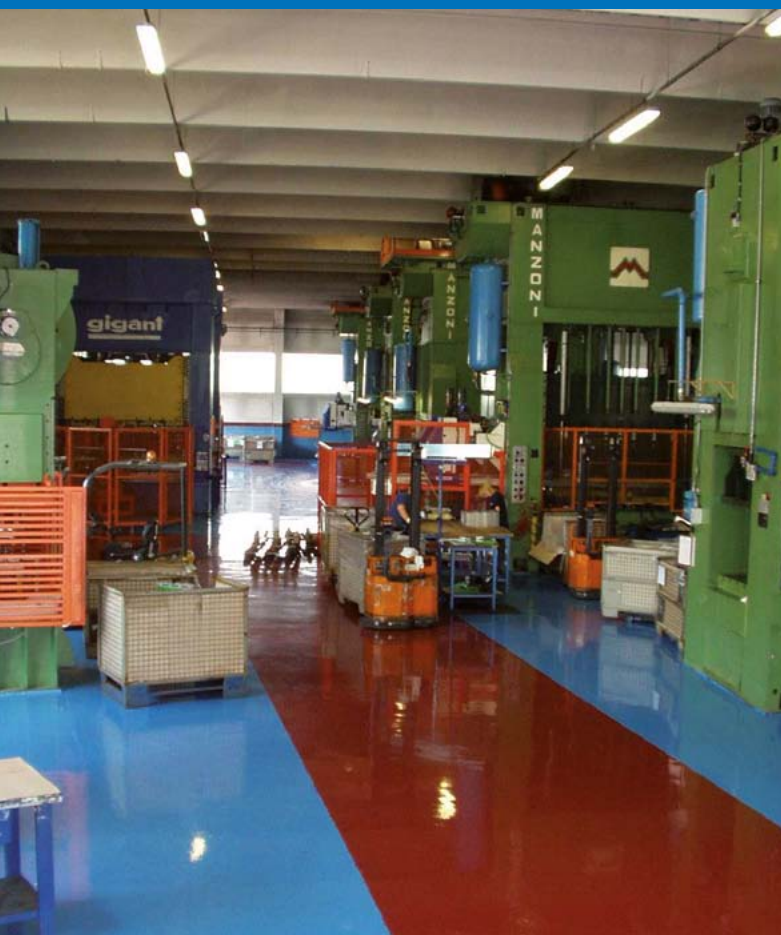
Цех Componenti Faist – Монтоне – Италия Напольные покрытия: Mapecolor System 33 , Mapecolor System 34
