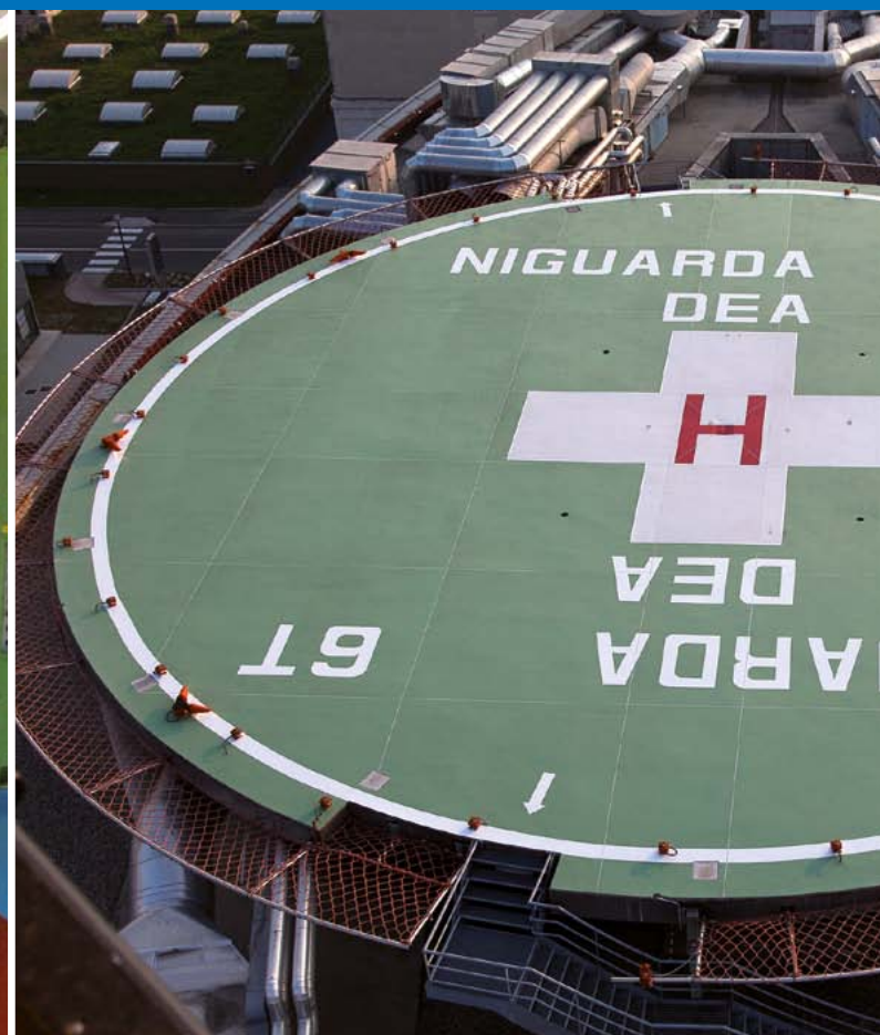
Вертолетная площадка больницы Niguarda – Милан – Италия Напольное покрытие: Mapecolor Parking System
