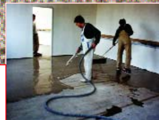
Завод MAGNA SREYR GROUP - Грац - Вена Австрия Подготовка основания: NIVORAPID, ULTRAPLAN, PRIMER G. Укладка натурального линолеума: AQUACOL T
