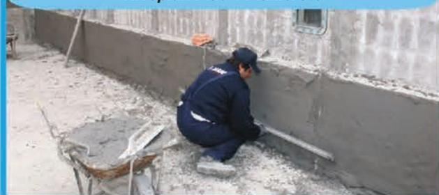
Если бетон изготовлен в соответствии со стандартом EN 206.1, хорошо уплотнен и выдержан с обеспечением не менее семи дней влажностного твердения, то чаша гарантированно будет иметь высокую водонепроницаемость без необходимости дополнительной гидроизоляции.
