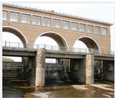
Общий вид сооружения до начала работ
