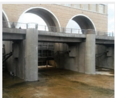
Окончательный вид сооружения после ремонта
