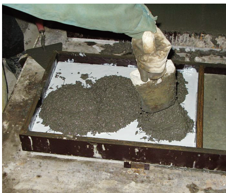
Рисунок П4 Укладка ремонтного материала АРБ-10Ф
