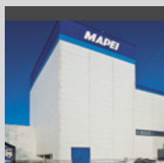
Завод г. Ступино, Московская обл.
