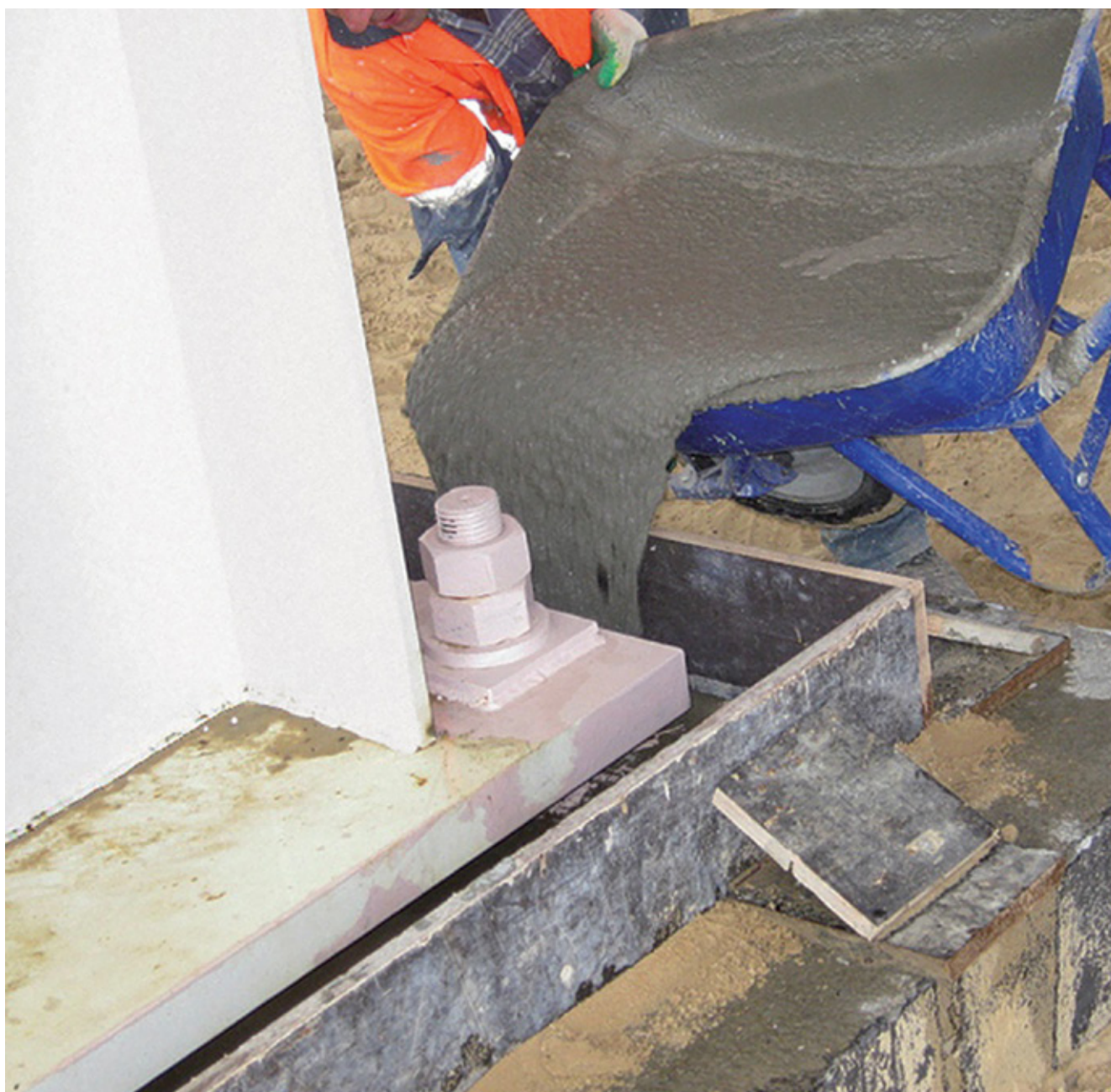
Решение 5. Подливка фундаментных болтов в анкерных колодцах
