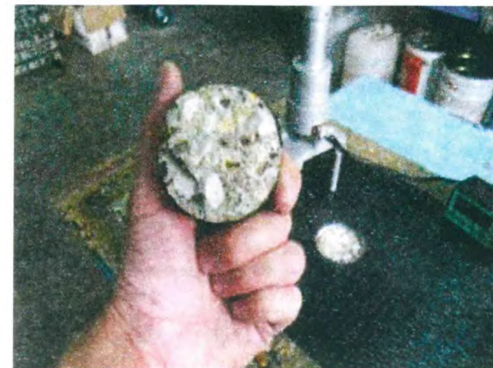
Рисунок Д.10 – Когезионное разрушение бетонной подложки
