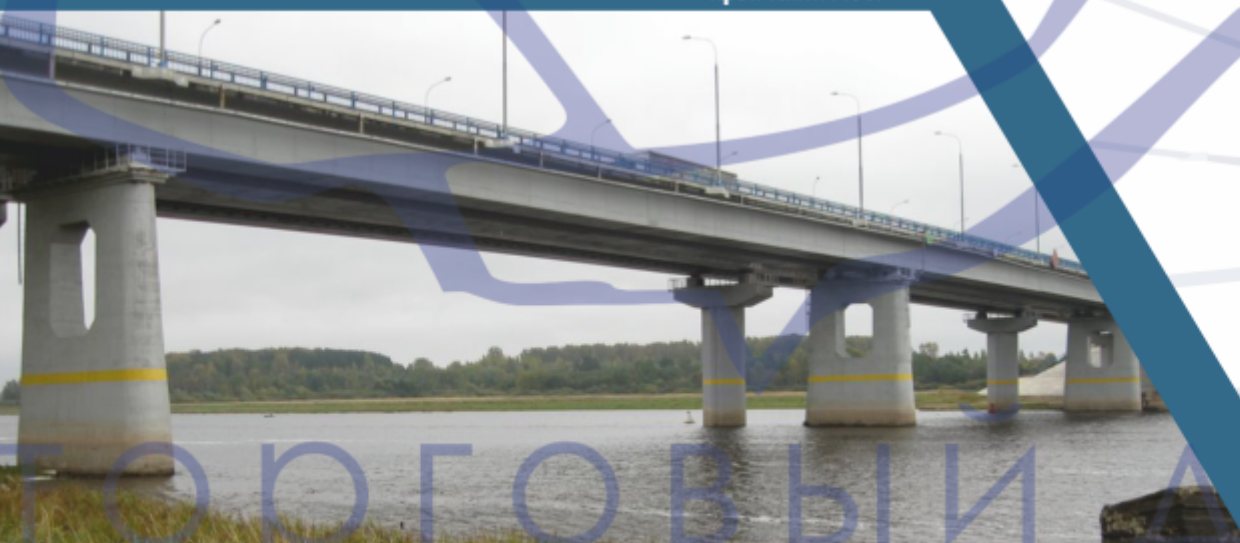
Мост через р. Волхов Великий Новгород
