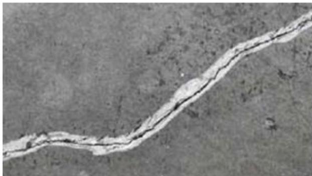
Рисунок 6. V-образная канавка вдоль трещины
