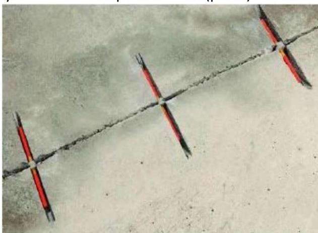
Рисунок 7. Установка стяжек в каналы, открытые в трещинах
