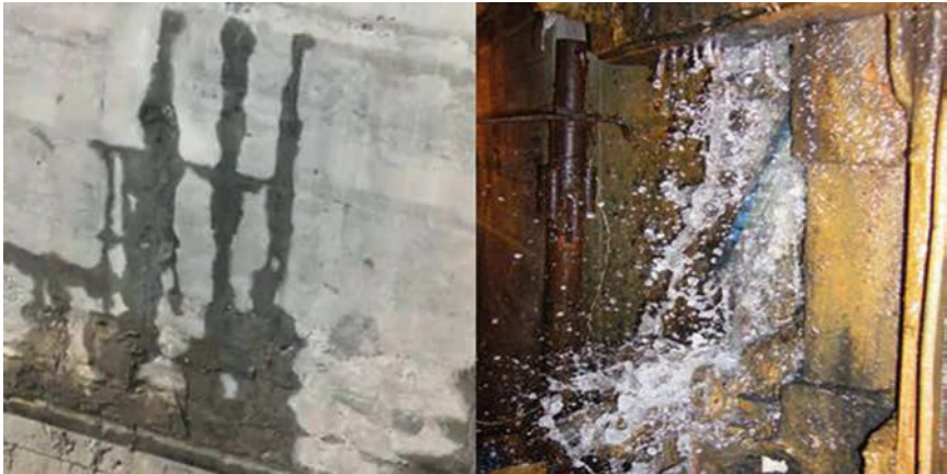
Рисунок 6.2.1 – Безнапорная и напорная течи
