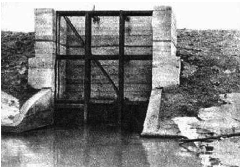
Рисунок 4.3.6 – Железобетонный водоспуск (водосброс)
