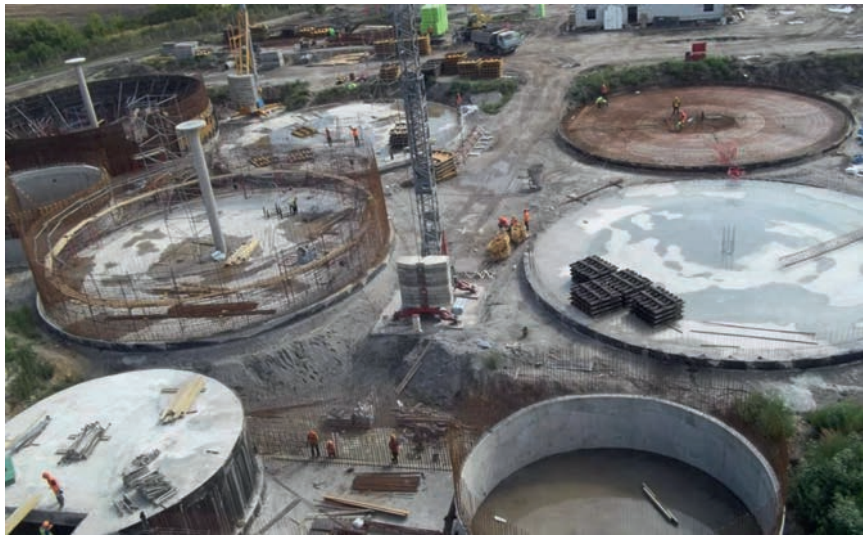
Рисунок 4.5.4 – Строительство биогазового комплекса
