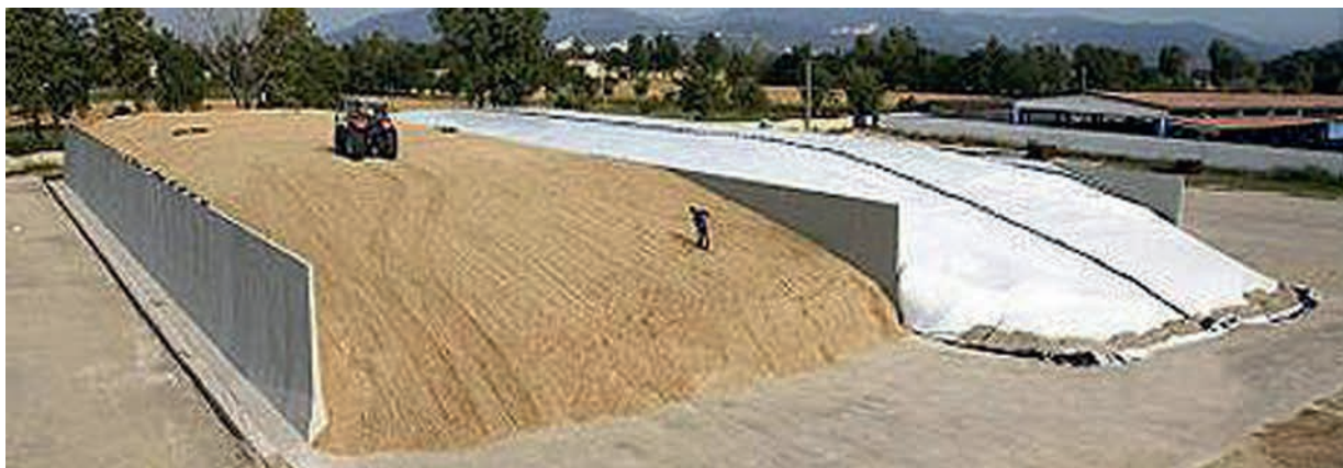
Рисунок 4.2.4 – Силосная траншея
