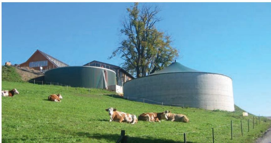
Рисунок 4.5.5 – Готовые биореакторы из монолитного железобетона
