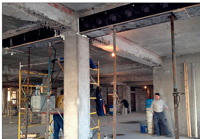
Рисунок 11 – Установка опалубки
