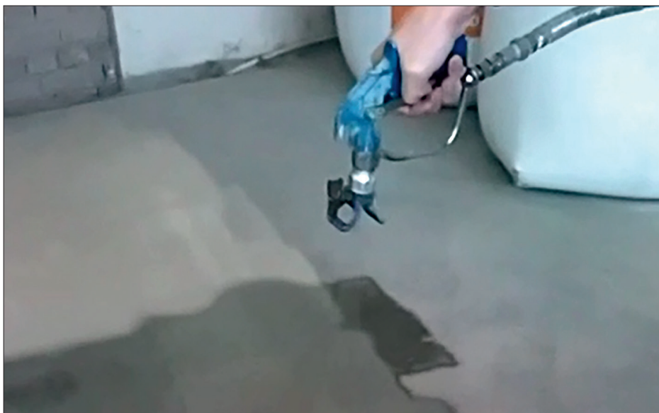
Рисунок 26 – Нанесение растворной смеси «Скрепа 2К Эластичная» аппаратом безвоздушного распыления
