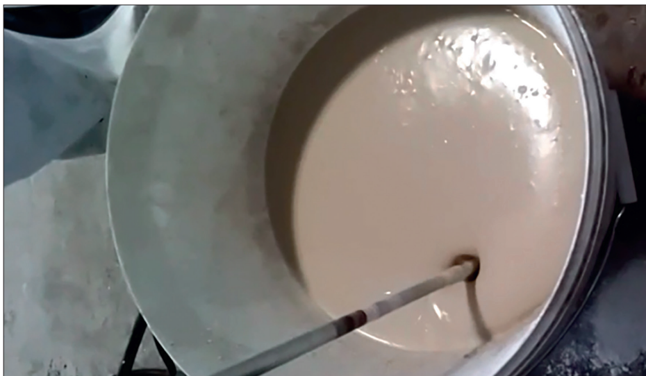
Рисунок 25 – Приготовление растворной смеси «Скрепа 2К Эластичная»
