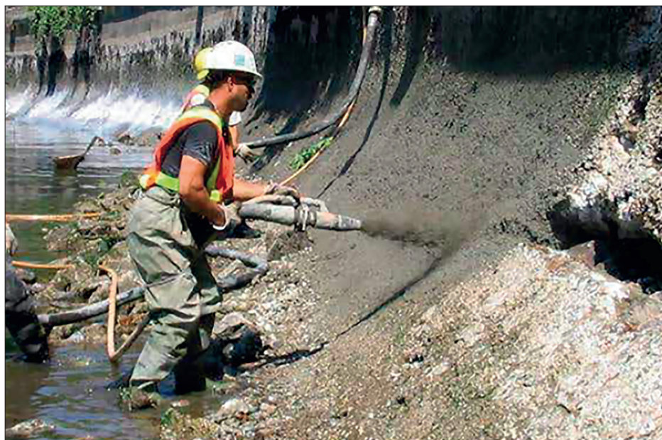
Рисунок 22 – Мокрое торкретирование
