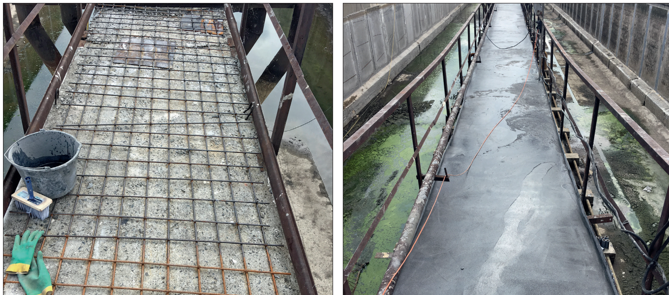
Рисунок 17 – Ремонт плит переходных мостиков (соотношение по массе: «Скрепа М600 Инъекционная»:Песок = 1:1)
