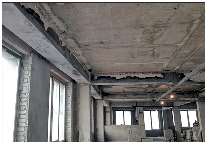
Рисунок 12 – Балка после восстановления
