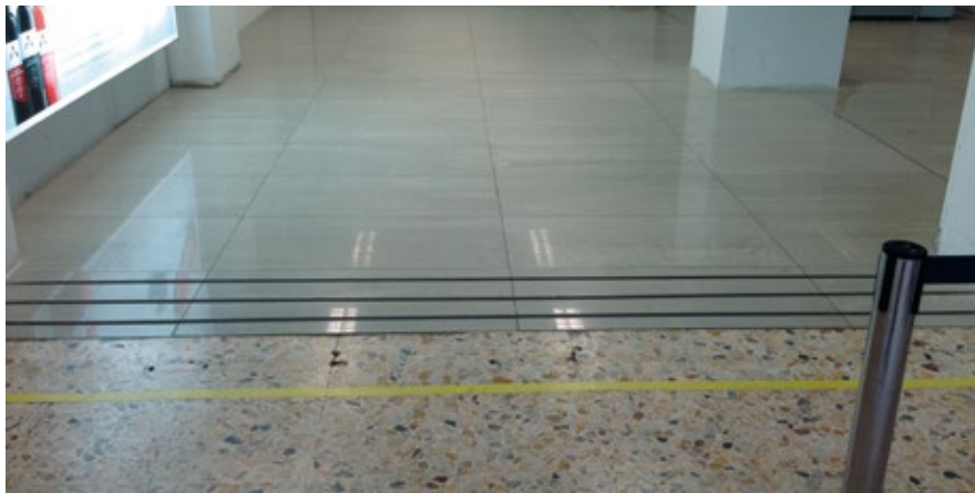
Укладка плитки поверх существующих полов
