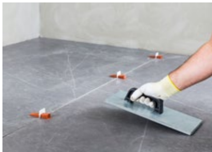
Простукивание плитки вручную или с помощью вибропанели
