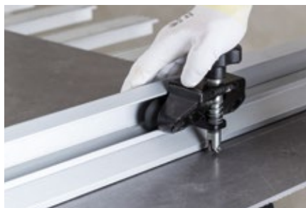
Резка плитки
