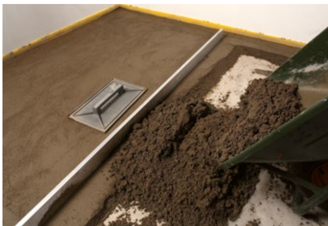
Укладка стяжки на основе ТОРЦЕМ PRONTO
