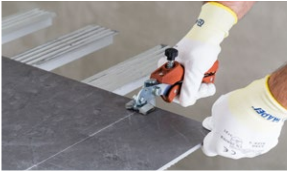
Разламывание плитки с помощью щипцов для надлома
