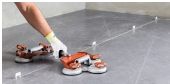
Позиционирующий инструмент
