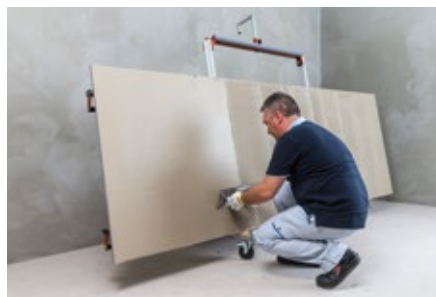
Клей наносится на основание и на плитку в одинаковом направлении
