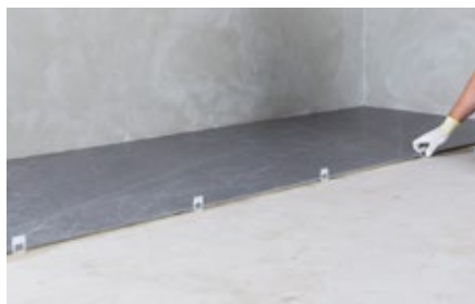
Установка разделителей в требуемое положение
