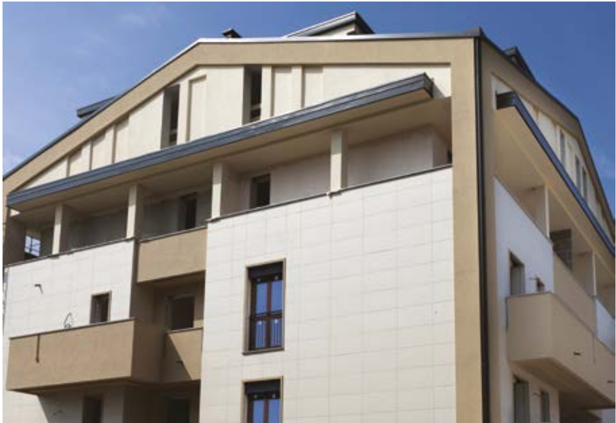
Укладка плитки на поверхность, подверженную воздействию солнечных лучей, с применением деформируемого клея (опциональный класс S1-S2)
