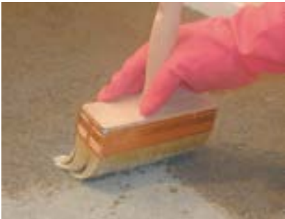
Нанесение PRIMER G кистью на поверхность стяжки
