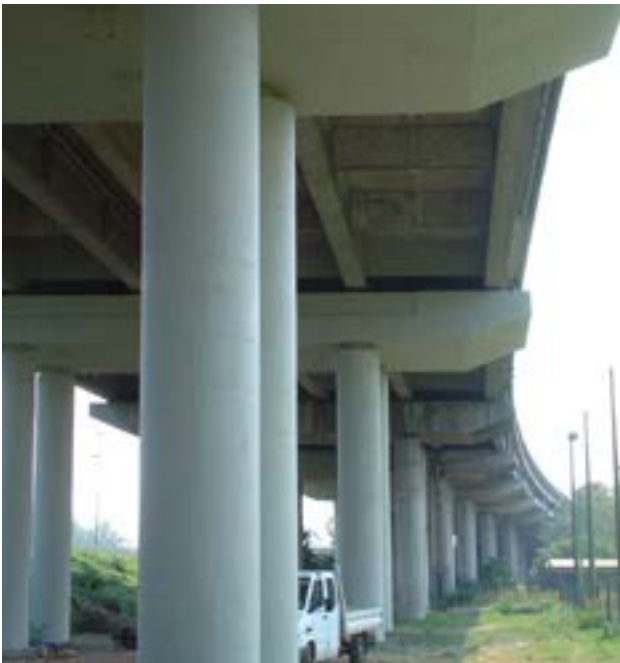
Защита и гидроизоляция с помощью двухкомпонентного эластичного цементного раствора MAPELASTIC , соответствующего требованиям ГОСТ 32017-2012. В качестве альтернативы возможно заглаживание и выравнивание однокомпонентным цементным раствором с высокой прочностью сцепления MONOFINISH или окрашивание эластичной защитной краской для бетона ELASTOCOLOR PAINT . Оба материала соответствуют требованиям ГОСТ 32017-2012
