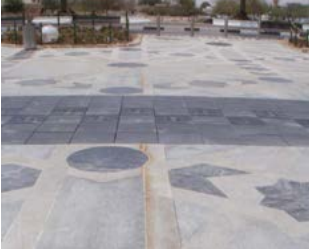
Пример появления пятен на поверхности натурального камня из-за использования герметика с полимеризацией на уксусной основе
