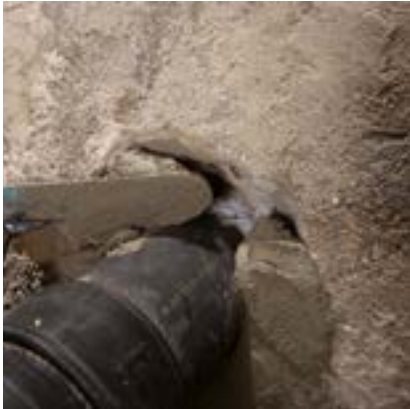
Нанесение Mapegrout Fast Set R4
