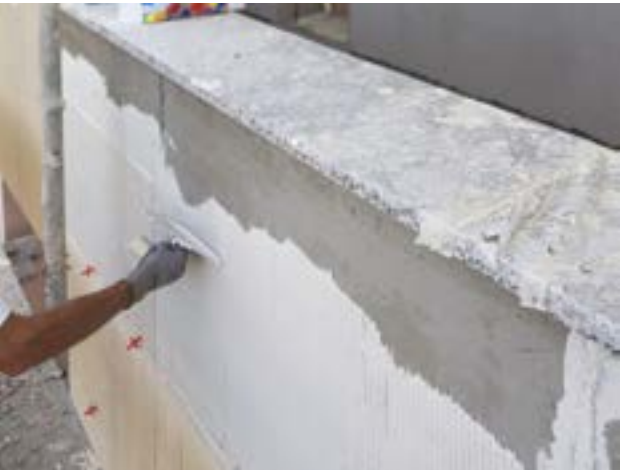
Нанесение клея на основание
