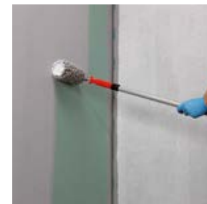
Укладка первого слоя MAPEGUM WPS
