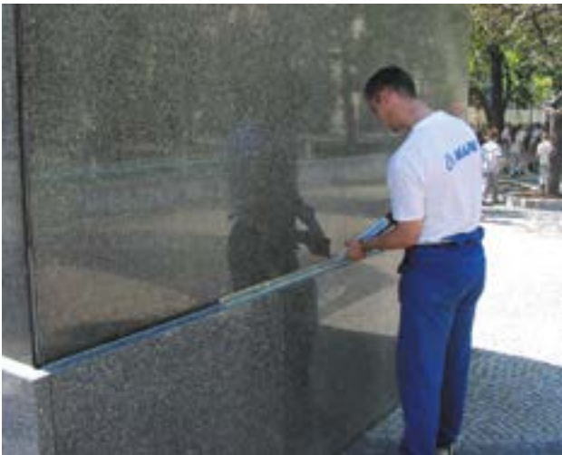
Герметизация швов на фасаде с помощью MAPESIL LM
