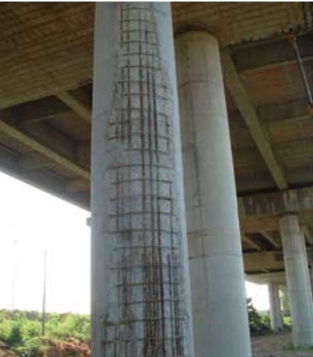
Подготовка основания с помощью гидроструйной обработки и гидроразрушения до получения прочной, чистой поверхности без отслаивающихся элементов
