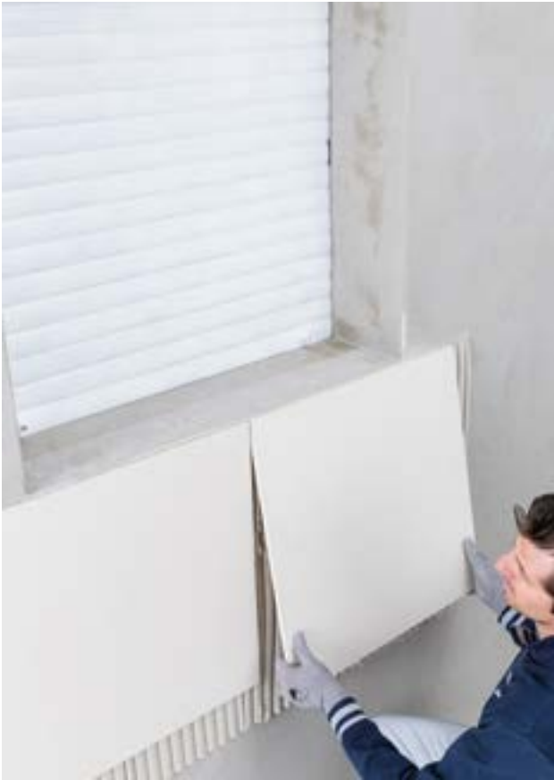
Укладка плитки на вертикальную поверхность с помощью тиксотропного клея
