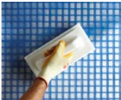
Очистка стеклянной мозаики после затирки
