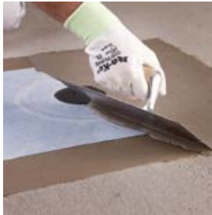
3. Нанесите поверх DRAIN VERTICAL / DRAIN LATERAL второй слой подходящей гидроизоляции MAPEI
