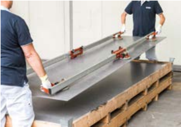
Перемещение плит с помощью специальных присосок
