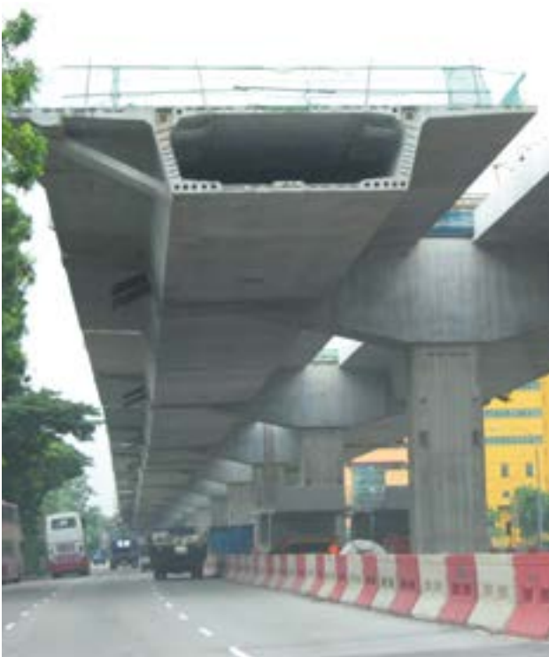
Конструктивное сцепление затвердевшего бетона с затвердевшим бетоном с помощью ADESILEX PG1 , конструкционного клея, сертифицированного согласно EN 1504-4
