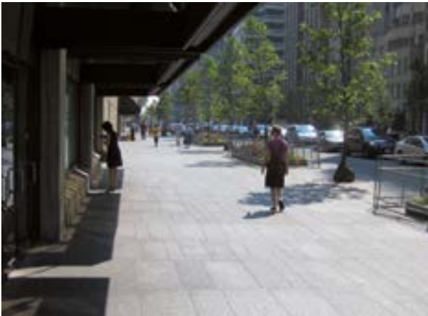
Пример укладки гранита с помощью GRANIRAPID , Блур Стрит, Торонто, Канада
