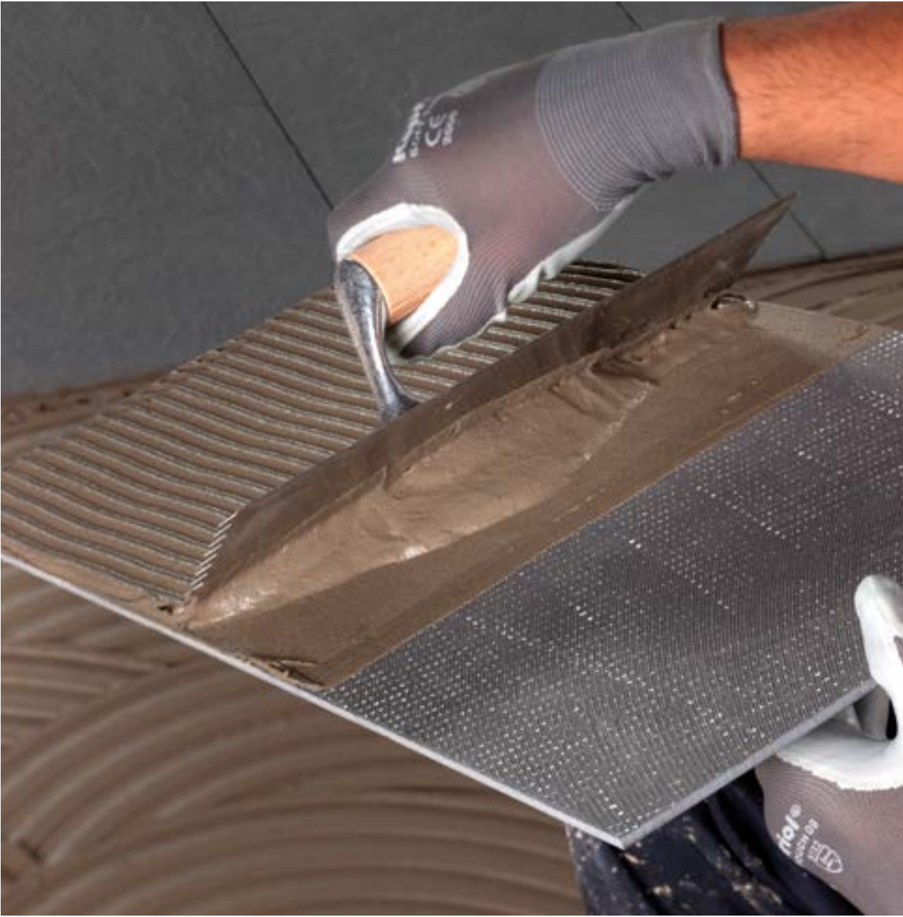
Укладка тонкого керамогранита с использованием метода двойного нанесения
