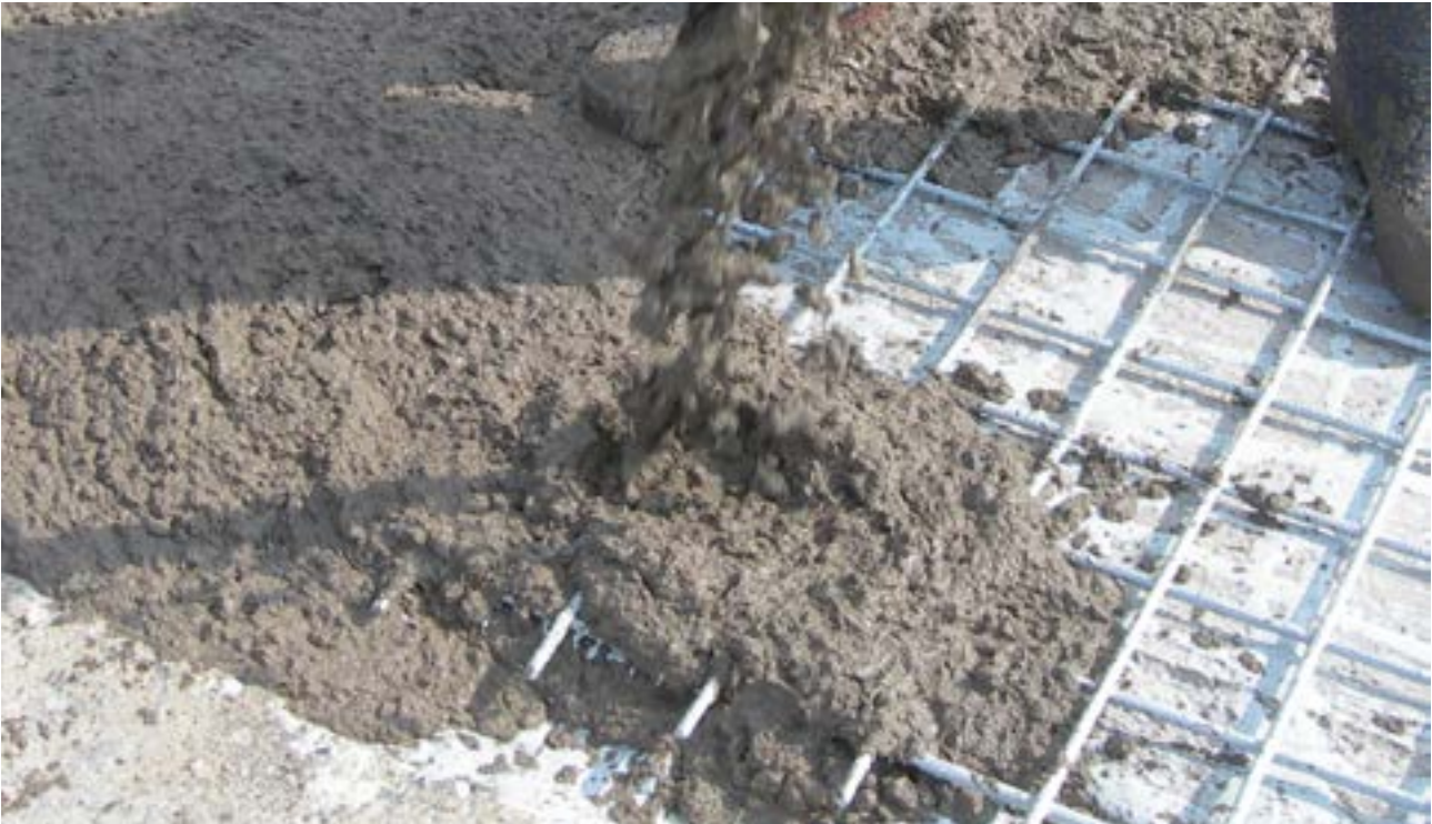
Конструктивное сцепление свежего бетона с затвердевшим бетоном с помощью EPORIP , конструкционного клея, сертифицированного согласно EN 1504-4
