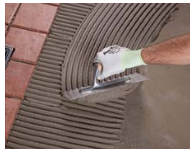
Нанесение плиточного клея
