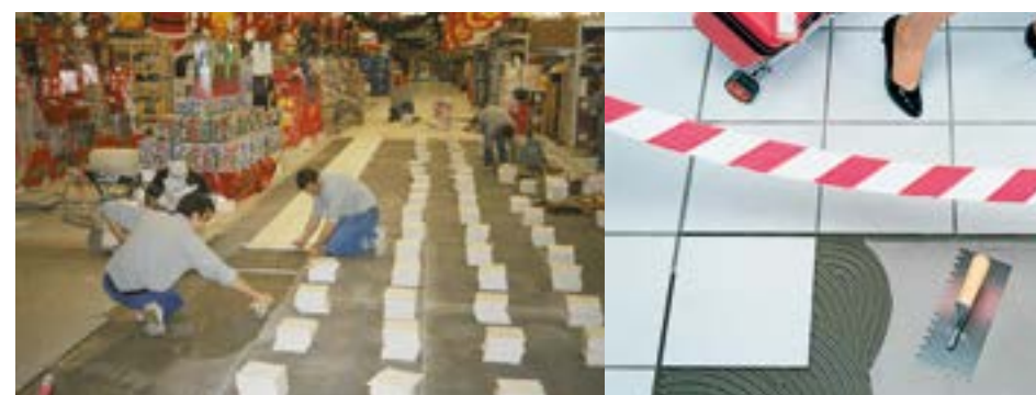
Быстрая укладка керамической плитки в торговом центре
