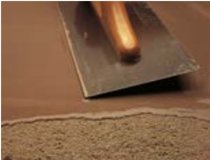
Финишное выравнивание с использованием ULTRAPLAN
