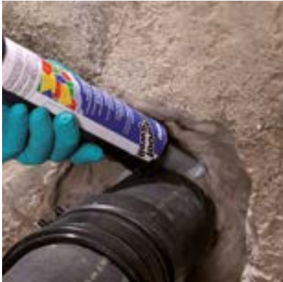
Нанесение Mapeproof Swell
