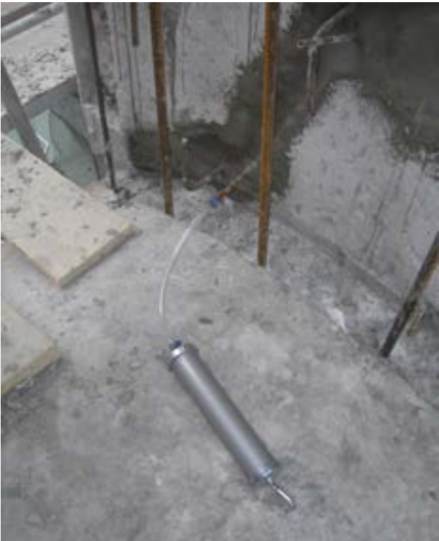
Инъектирование сверхтекучей эпоксидной смолой EPOJET , EPOJET LV . Демонтаж пакеров после схватывания
