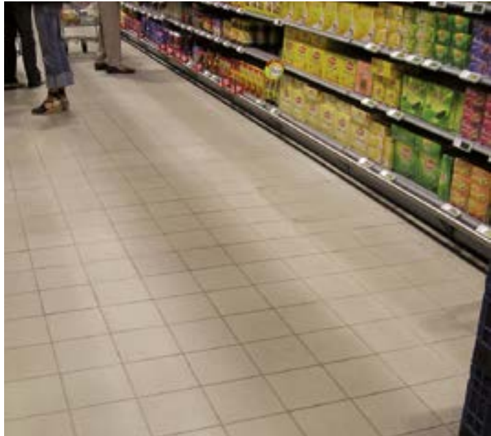
Пол в супермаркете подвергается нагрузкам из-за большой проходимости, поэтому укладка плитки требует техники двойного нанесения
