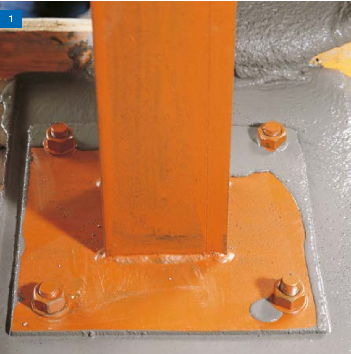
Решение 1. Анкеровка металлических конструкций с помощью подливочных составов
