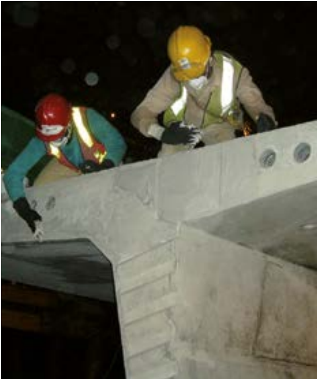
Конструктивное сцепление затвердевшего бетона с затвердевшим бетоном с помощью ADESILEX PG1 , конструкционного клея, сертифицированного согласно EN 1504-4
