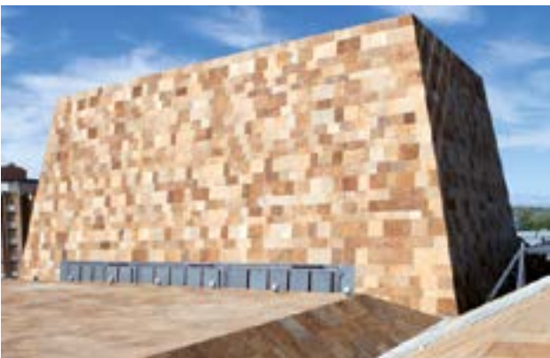
Пример укладки натурального камня на фасад. Конгресс-центр La Llotja, Льейда — Испания
