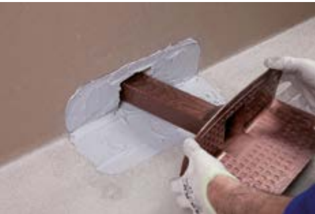
3. Установите DRAIN FRONT и слегка надавите его для того, чтобы утопить его в ADESILEX PG4
