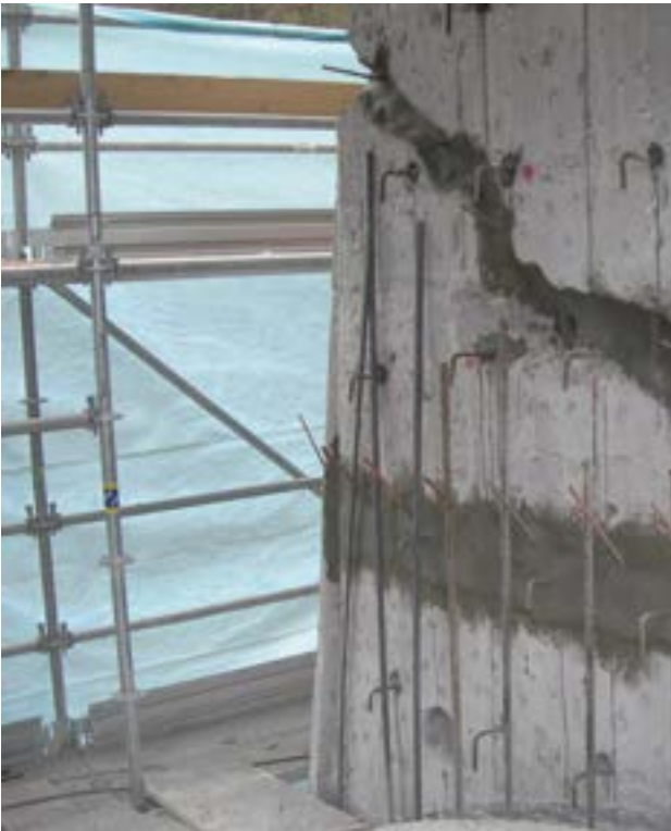
Поверхностная заделка трещины с применением двухкомпонентного тиксотропного эпоксидного клея для конструкционного склеивания ADESILEX PG1 , ADESILEX PG2
