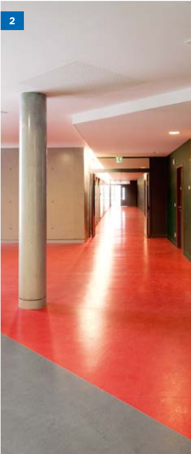
Решение 2. Укладка каучукового покрытия в образовательных и медицинских учреждениях
