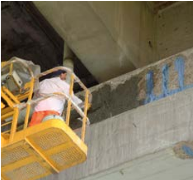
Восстановление слоя бетона с использованием конструкционного раствора класса R4 MAPEGROUT EASY FLOW , соответствующего требованиям ГОСТ Р 56378-2015
