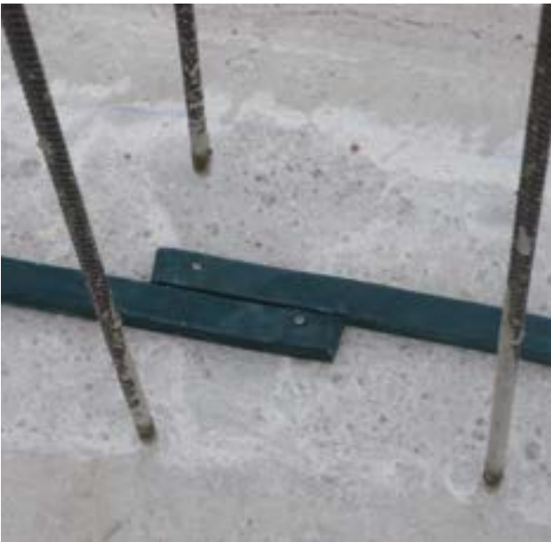
Соединение двух отрезков Idrostop
