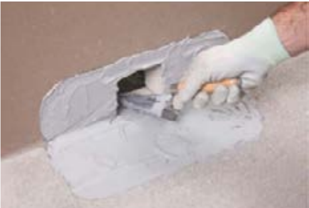
2. На чистое и сухое основание нанесите с помощью шпателя равномерный слой двухкомпонентного эпоксидного клея ADESILEX PG4
