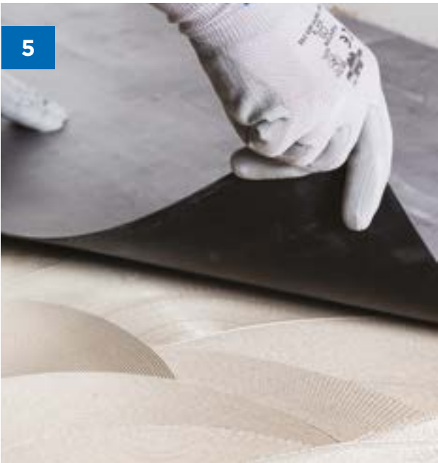
Решение 5. Укладка LVT-плитки во влажных помещениях
