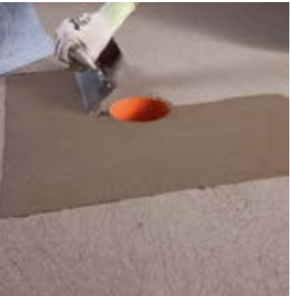
1. Вокруг сливного отверстия нанесите первый слой подходящей гидроизоляции MAPEI с выходом за пределы нетканого покрытия
