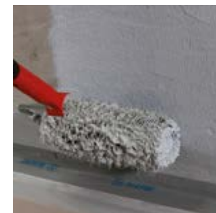
Нанесение MAPEGUM WPS с помощью валика
