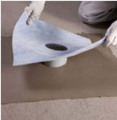
2. Уложите DRAIN VERTICAL / DRAIN LATERAL поверх свеженанесенной гидроизоляции MAPEI
