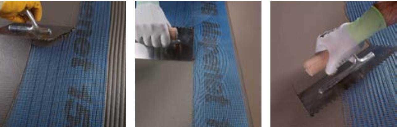
Нанесение MAPELASTIC на MAPENET 150
