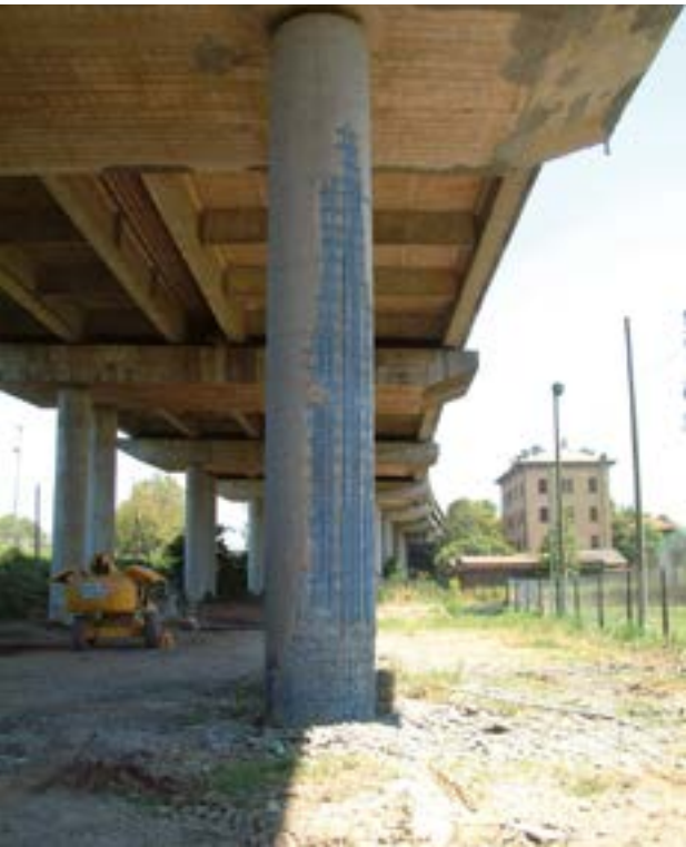
Пассивация арматурной стали с применением однокомпонентного антикоррозионного цементного раствора MAPEFER 1K
