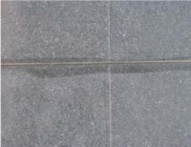
Пример появления пятен на поверхности натурального камня.
