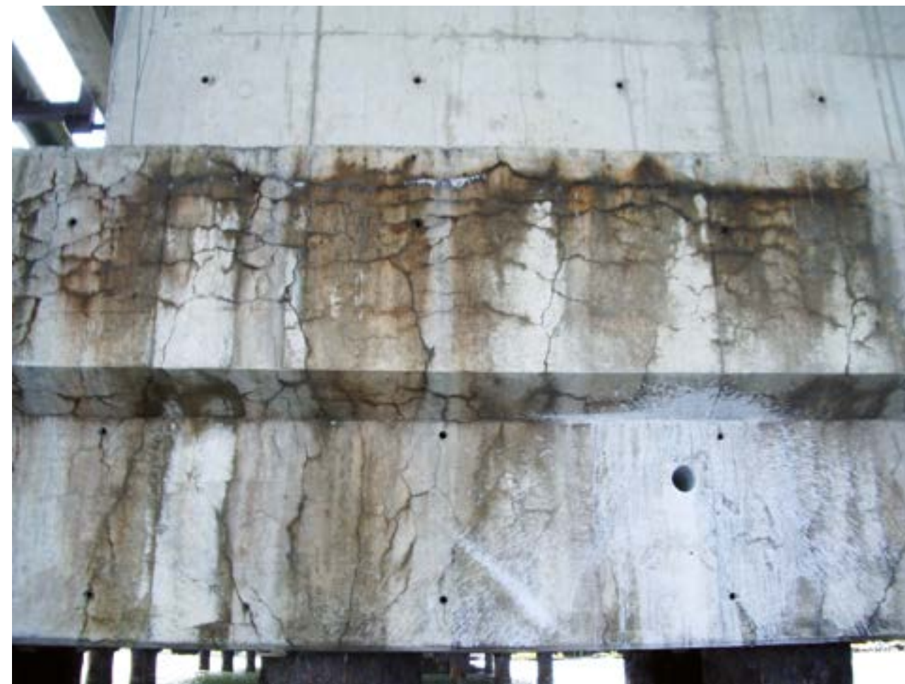
Рис. 11. Разрушение из-за реакции взаимодействия щелочей цемента с заполнителями бетона
