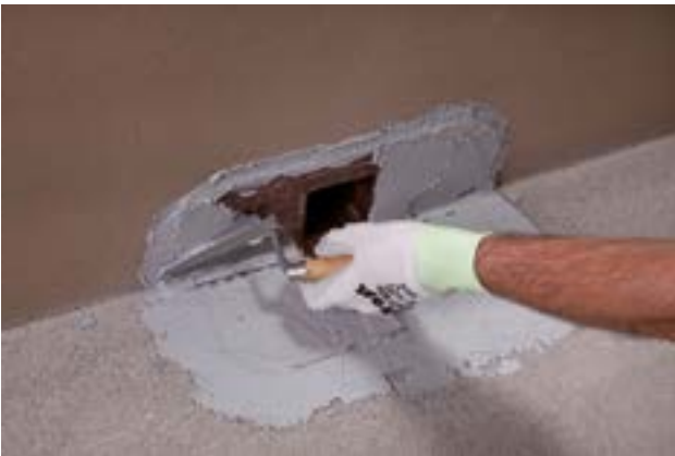
4. Нанесите второй слой ADESILEX PG4 методом «мокрое по мокрому», чтобы полностью скрыть DRAIN FRONT. Обсыпьте свежий слой PG4 песком для создания шероховатой поверхности
