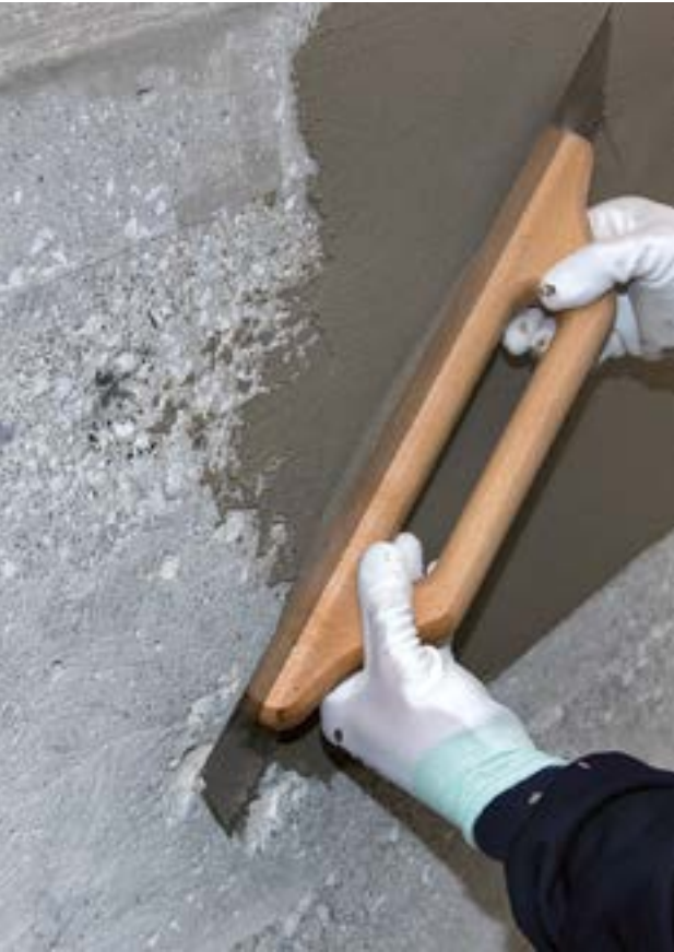
Нанесение тиксотропного выравнивающего состава на стену
