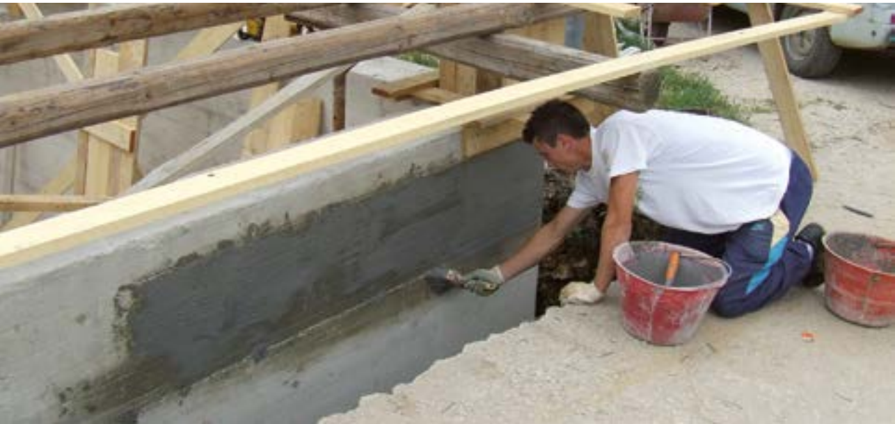
Нанесение MAPELASTIC FOUNDATION
