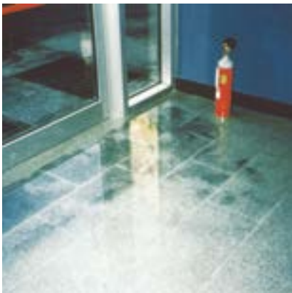
Пример пятен на гранитном полу
