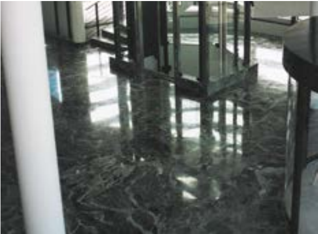
Пример укладки мрамора Verde Alpi с помощью KERALASTIC . Rolex Hall — Биль, Швейцария
