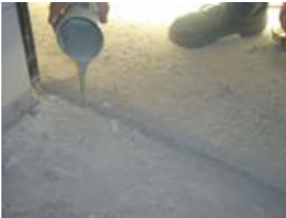
Ремонт трещин с помощью EPORIP
