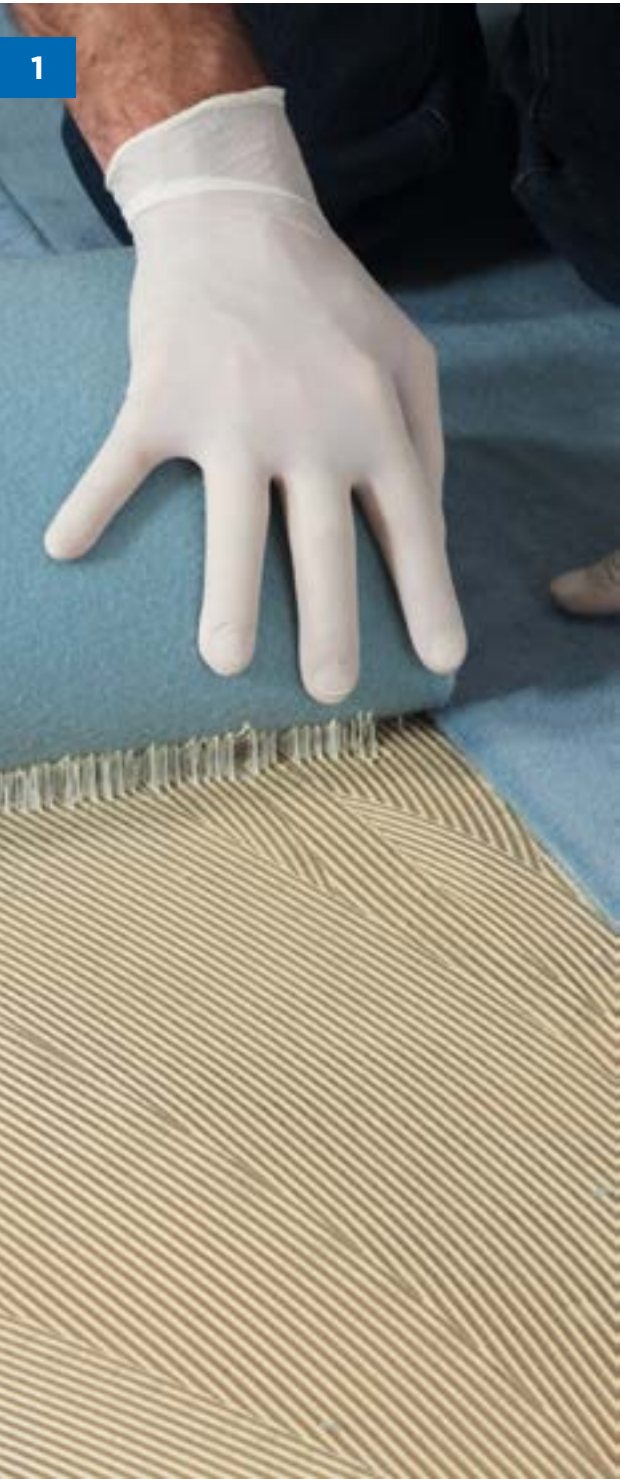
Решение 1. Укладка текстильного напольного покрытия в общественных и бытовых помещениях
