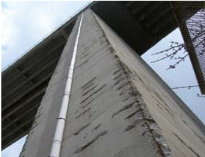
Рис. 3. Пример разрушения, вызванного внешней средой
