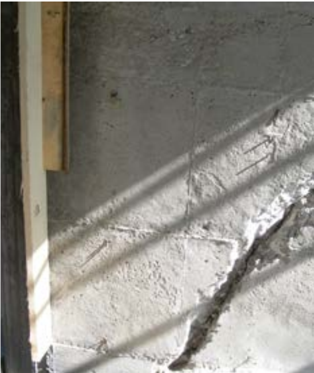
Вскрытие трещины с последующим выдуванием и очисткой всей пыли. Упаковка специальных инъекционных пакеров
