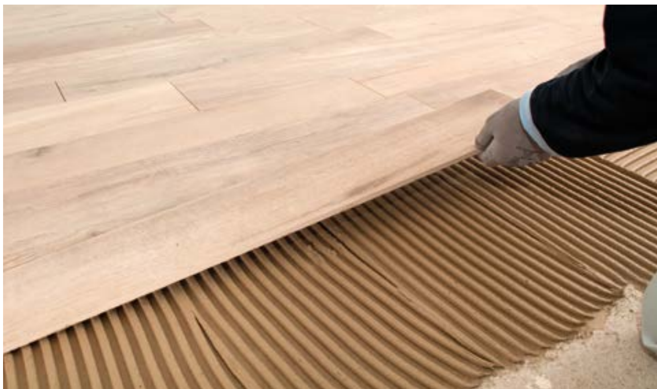
Укладка крупноформатной плитки с эффектом «под дерево»
