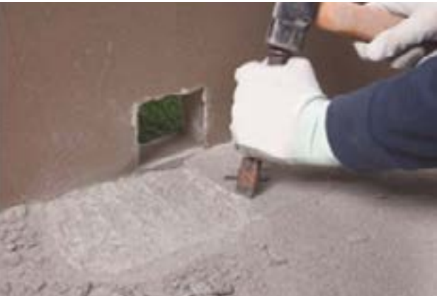
1. Подготовьте основание под установку DRAIN FRONT
