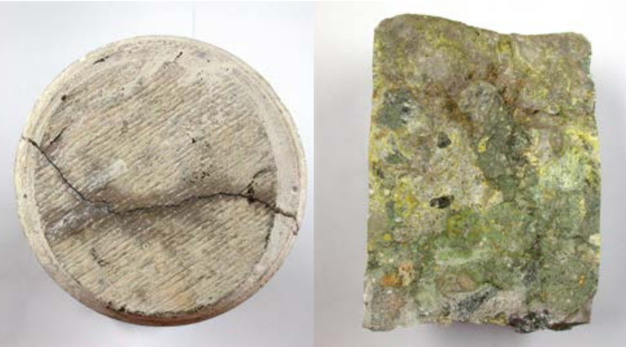
Рис. 12. Образец, взятый из сердцевины бетона, разрушенной структуры
