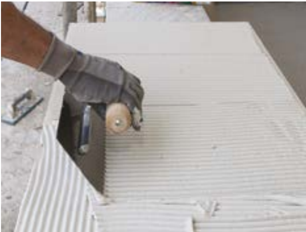
Нанесение клея на обратную сторону плитки
