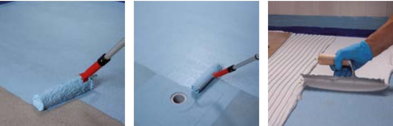
Укладка первого слоя по стяжке пола Mapelastich Aquadefense
