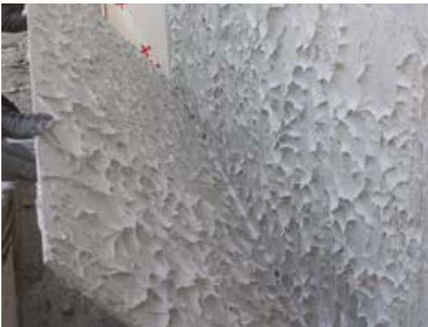
Проверка смачивания клеем плитки
