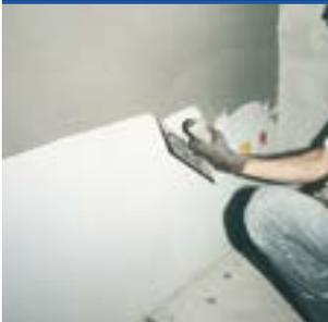
**Готовый к применению материал в виде сухой смеси, созданный на основе специального цементного вяжущего, мелкого фракционированного песка и специальных добавок.**
