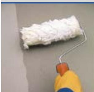
**Укрепляющая грунтовка с высокой проникающей способностью, на основе растворителя, для выравнивания поверхностей.**
