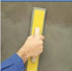
**При смешивании двух компонентов (А - порошок и В - жидкость) образуется пластичный раствор, обладающий тиксотропными свойствами, что позволяет его использовать для выравнивания и чистовой отделки вертикальных и потолочных бетонных поверхностей.**
