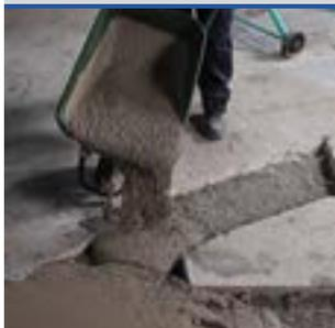
**Быстрохватывающаяся и быстротвердеющая высокотекучая ремонтная смесь с контролируемой усадкой, применяемая для ремонта бетона при пониженных температурах до -5°C. Используется в сочетании с жесткой стальной фиброй.**
