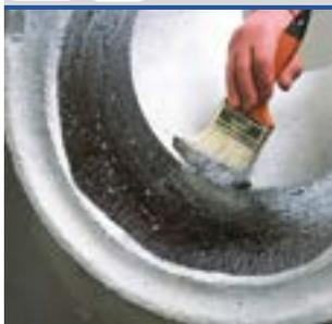
*Двухкомпонентная, противокислотная эпоксидная краска, модифицированная гидрокарбонатной смолой для защиты бетонных и стальных поверхностей.*
