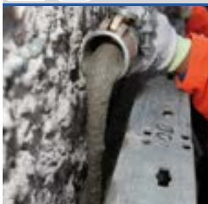
**Готовый к применению материал в виде сухой смеси, созданный на основе высокопрочного цемента, фракционированного песка и гравия, специальных добавок, содержит полимерную фибру.**
