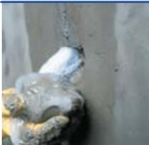
**Сверхбыстрохватывающееся и быстротвердеющее гидравлическое вяжущее для остановки водных протечек. Предназначен для немедленной остановки водных протечек даже там, где имеется напор воды.**
