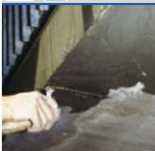
**Готовый к применению материал в виде сухой смеси, созданный на основе высокопрочного цемента, фракционированного песка и специальных добавок, содержит полимерную фибру.**
