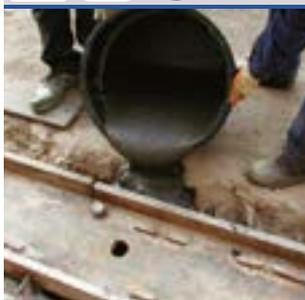
**Высокотекучий трехкомпонентный эпоксидный раствор с толщиной заливки до 10 см для анкеровки и заполнения конструкций.**
