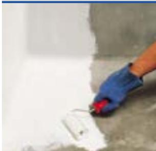
*Двухкомпонентная эпоксидная краска для устройства противокислотных покрытий на бетонных поверхностях.*
