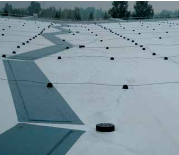
Пешеходная дорожка на кровле завода VELUX в Великом Новгороде
