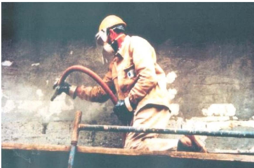
Рис. 22. Очистка поверхности с помощью пескоструйной установки
