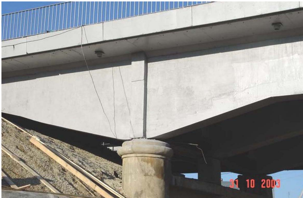
Рис. 27. Отремонтированное пролетное пространство
