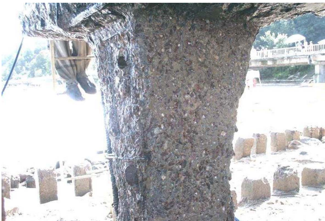
Рис. 19. Бетонная опора, подготовленная к ремонту
