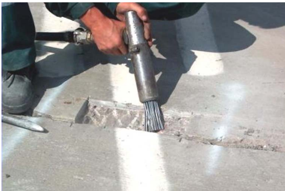
Рис. 14. Подготовка бетона игольчатым пистолетом
