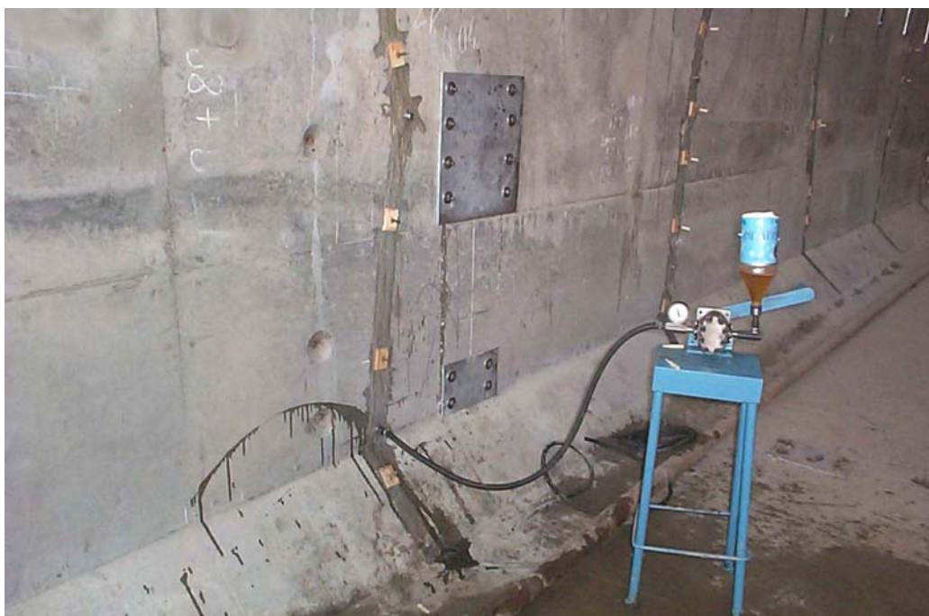
Рис. 33. Инъектирование трещин по высоконапорной технологии
