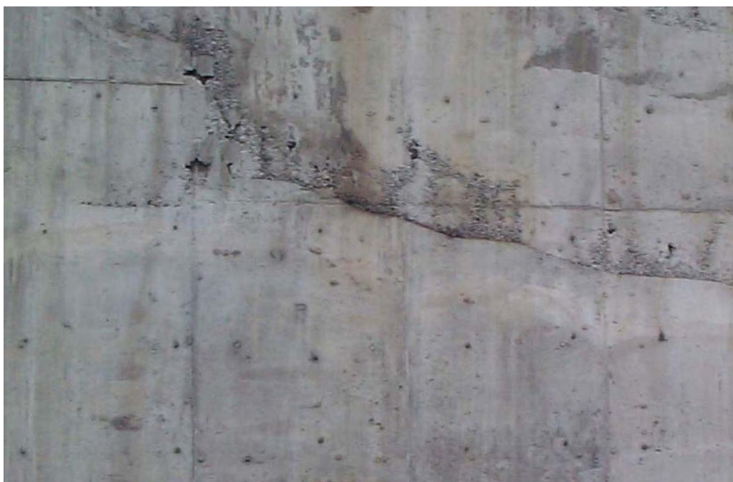
Рис. 3. Щебенистость на поверхности стены и полости, незаполненные бетоном
