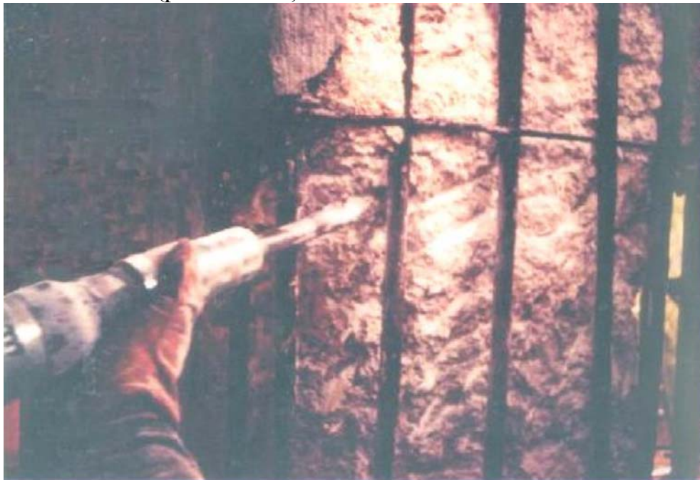
Рис. 13. Подготовка поверхности с помощью бучарды
