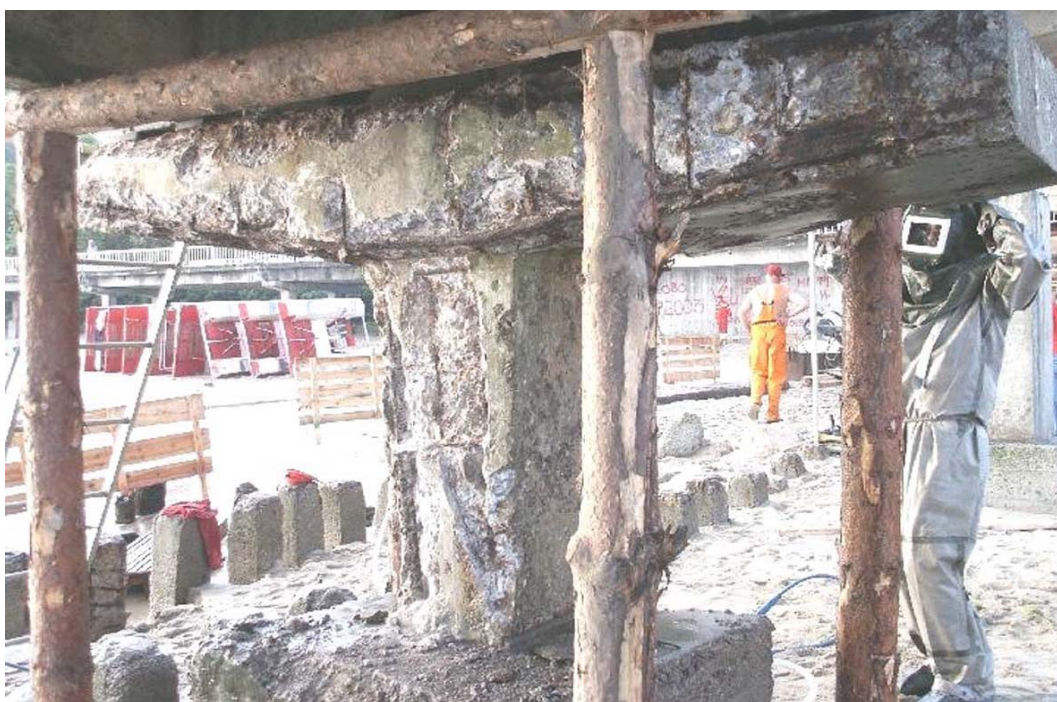
Рис. 8. Разрушение бетона маломассивной опоры с оголением и коррозией арматуры
