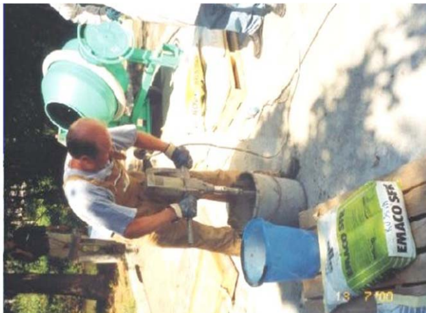
Рис. 12. Приготовление ремонтных смесей ЭМАКО на различном оборудовании: а) в бетономешалке; б) с помощью дрели с насадкой
