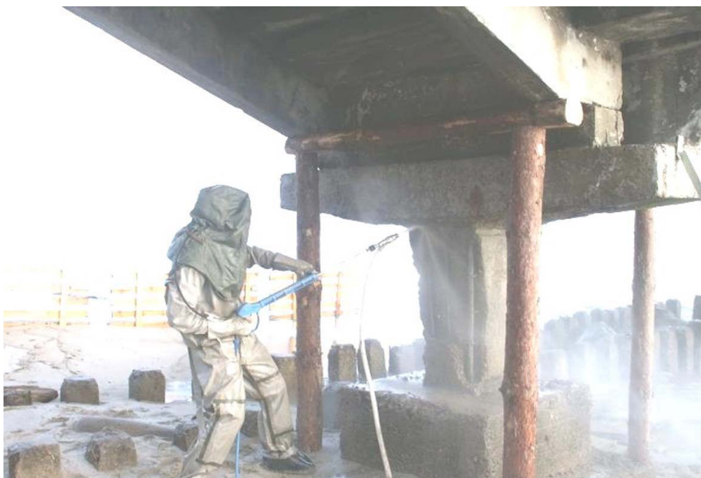
Рис. 21. Очистка поверхности бетона помощью водопескоструйной установки
