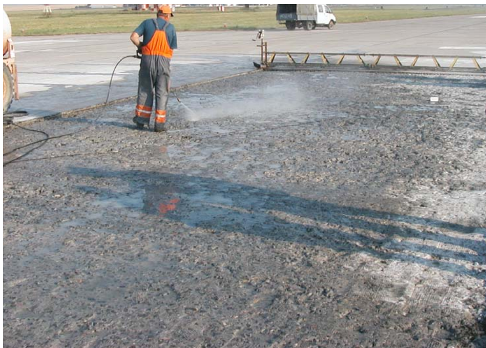
Рисунок 3 – Насыщение поверхности водой
