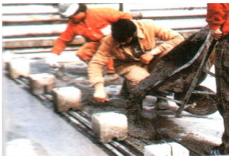
Рисунок 5 – Заливка бетонной смеси с помощью тележки с разравниванием
