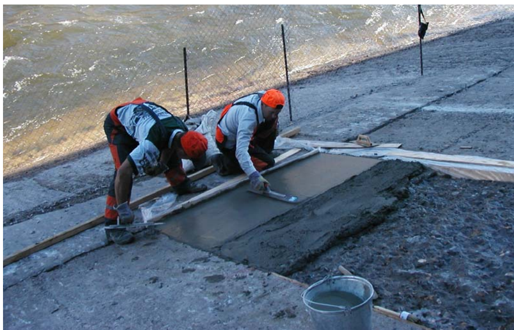
Рисунок 8 – Укладка бетонной смеси мастерком и разглаживание поверхности теркой
