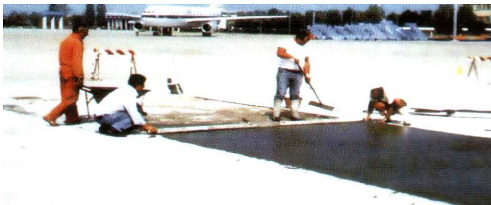
Рисунок 7 – Выравнивание поверхности рейкой
