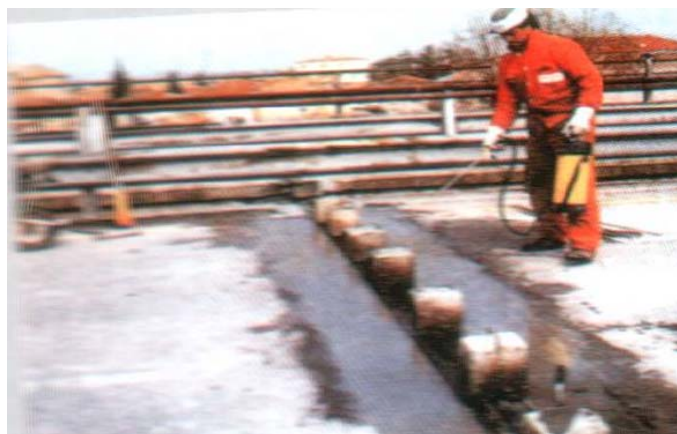
Рисунок 9. Увлажнение поверхности путем распыления воды
