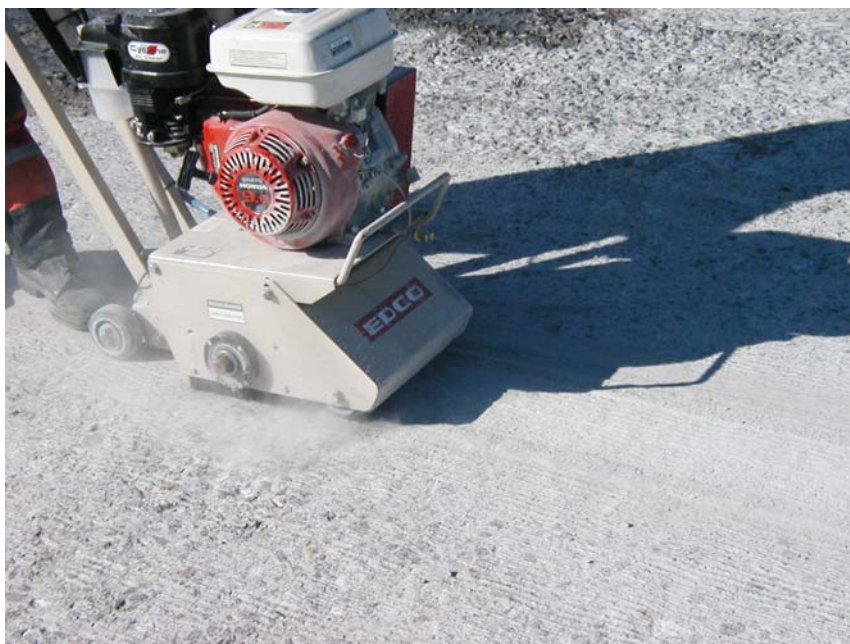
Рисунок 1 – Подготовка поверхности механическим способом
