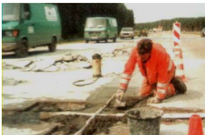
Рисунок 6 – Укладка бетонной смеси вручную с разравниванием
