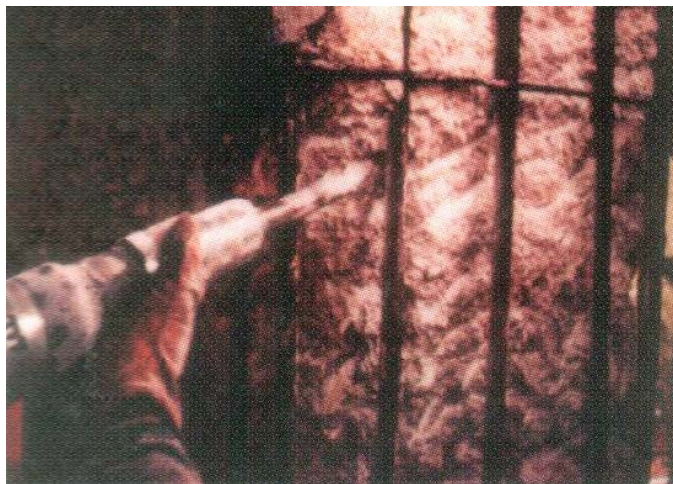
Рисунок 1 – Подготовка поверхности с помощью перфоратора
