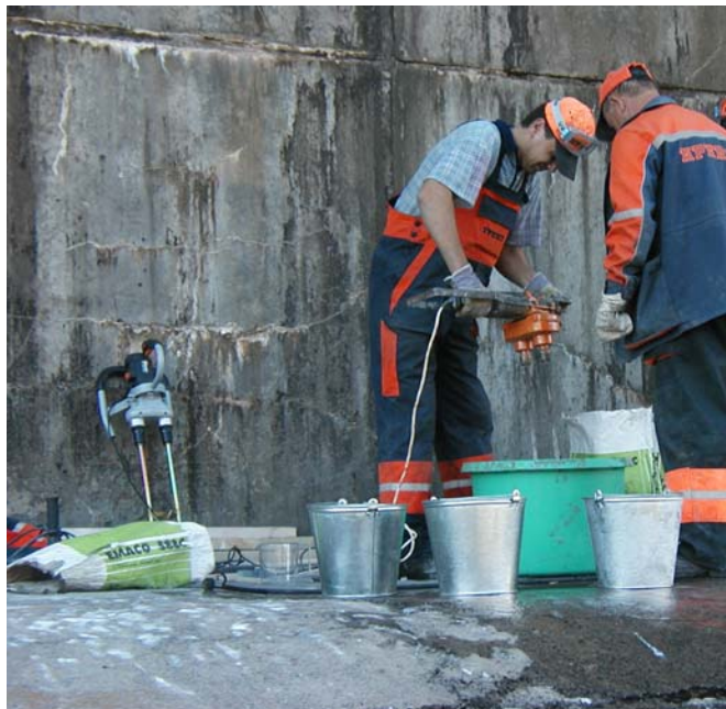
Рисунок 4 - Приготовление бетонной смеси в миксере
