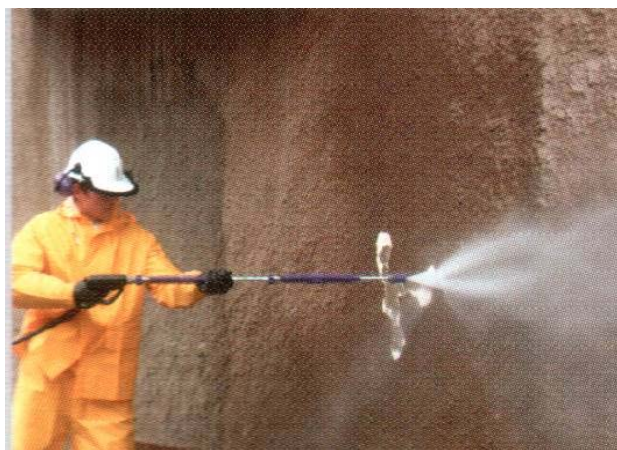
Рисунок 2 – Подготовка поверхности с помощью водоструйной установки
