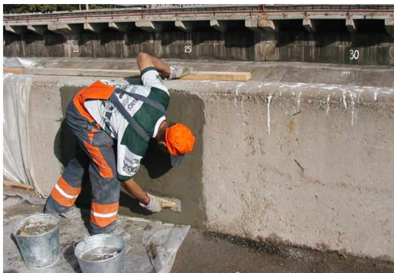
Рисунок 5 – Нанесение ремонтного состава теркой из нержавеющей стали
