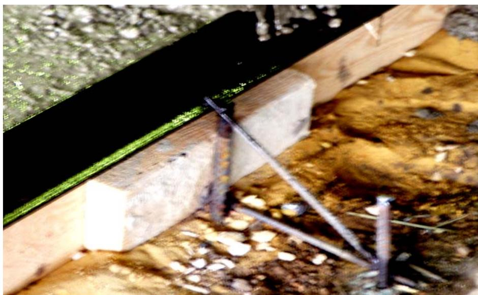
Рис. 11. Схема приваривания уголков опалубки к анкерам
